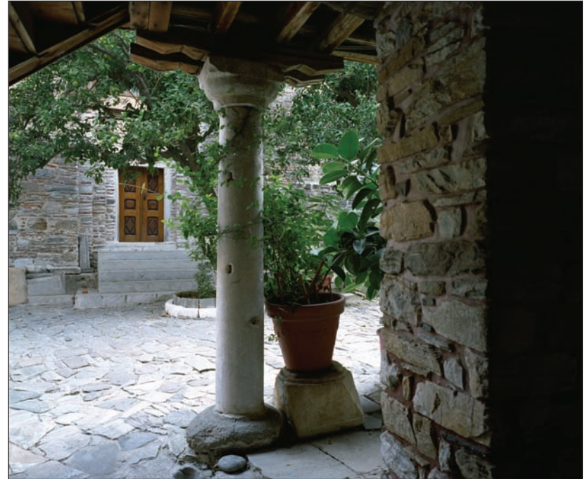
Φωτ.20 Ο ένας από τους δύο αρχαίους κίονες που χρησιμοποιείται ως πεσσός στο ισόγειο της νότιας κόρδας.
