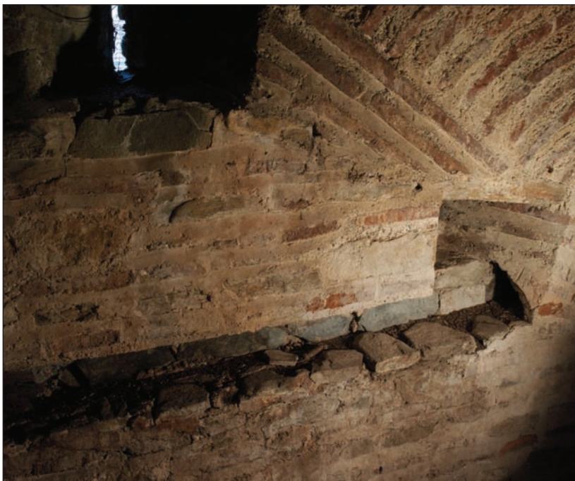
Φωτ.61 Ίχνος εντός της Β τοικοποιίας της προ του Υπερώου διόδου, προϋπάρχουσας εμμεγέθους μάντωσης, που έχει εντελώς αποσυντεθεί.
