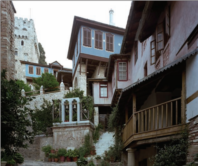
Φωτ.26 Ο αναληπτικός τοίχος που διαμορφώνει το ανατολικό τμήμα της αυλής πίσω από το ιερό του Καθολικού.
