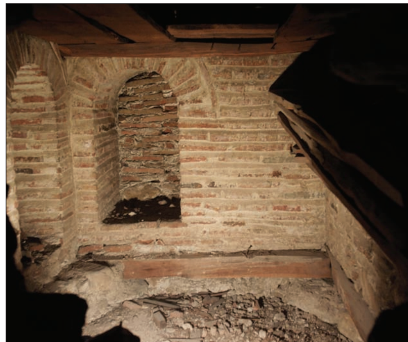
Φωτ.44 Ο ΝΔ τυφλός χώρος πάνω από το Καθολικό, όπου διακρίνονται οι ξύλινες ενισχύσεις περίδεσης και το ίχνος της οκτάπλευρης του βάσης.
