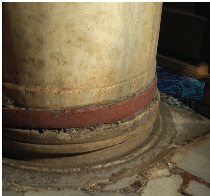
Φωτ.51 Λεπτομέρεια στήριξης επί της βάσης του ΒΑ κίονα.
