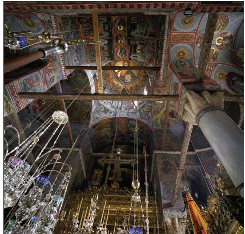
Φωτ.49 Ξύλινες ενισχύσεις σε δύο επίπεδα εντός του Καθολικού.
