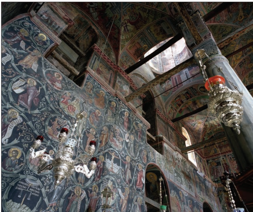
Φωτ.41 Ανώτερη σειρά ανοιγμάτων της Λιτής στον Β τοίχο, όπου διακρίνονται σε απόλυτη αντιστοιχία οι εντός και εκτός της τοικοποιίας ξύλινες ενισχύσεις.
