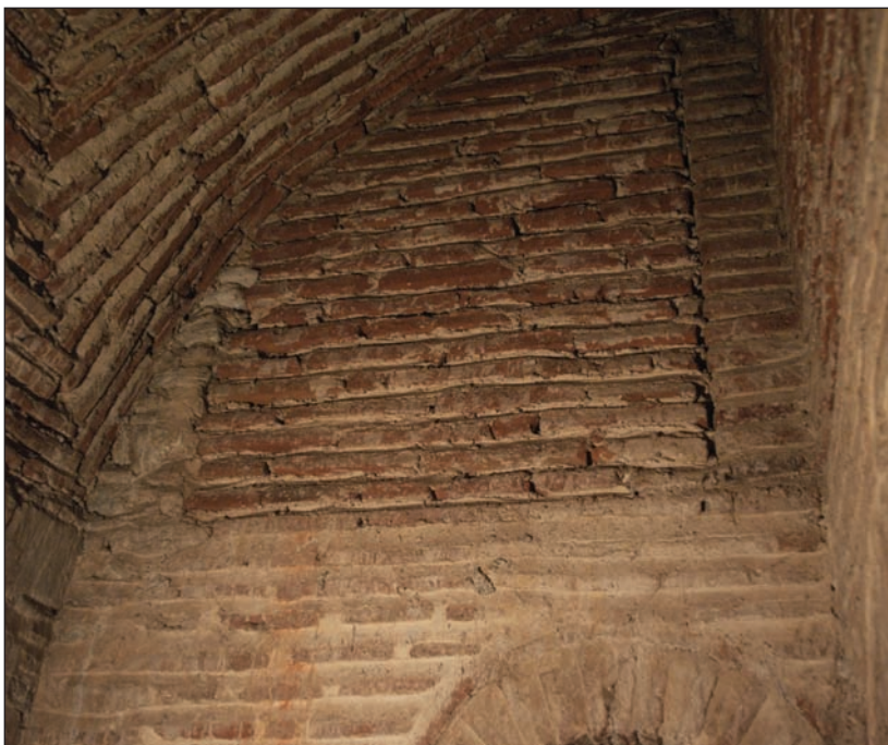
Φωτ.43 Εσωτερική άποψη του ΒΔ, μη προσβάσιμου, χώρου υπεράνω της αντίστοιχης περιοχής του κυρίως ναού.
