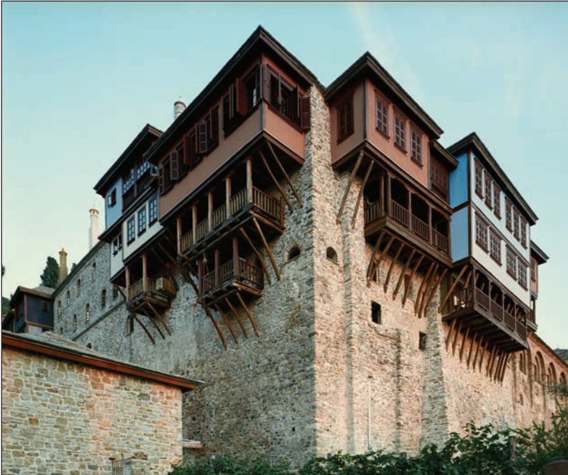
Φωτ.15 Βορειοδυτική γωνία του οχυρωματικού τοίχους της Μονής με τα χαρακτηριστικά νεότερα ξύλινα προεκτάσματα.
