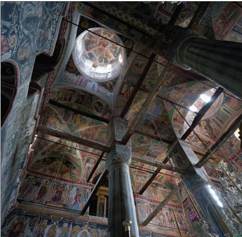
Φωτ.48 Ξύλινες ενισχύσεις εκτός των τοίχων σε δύο επίπεδα μέσα στην Λιτή.
