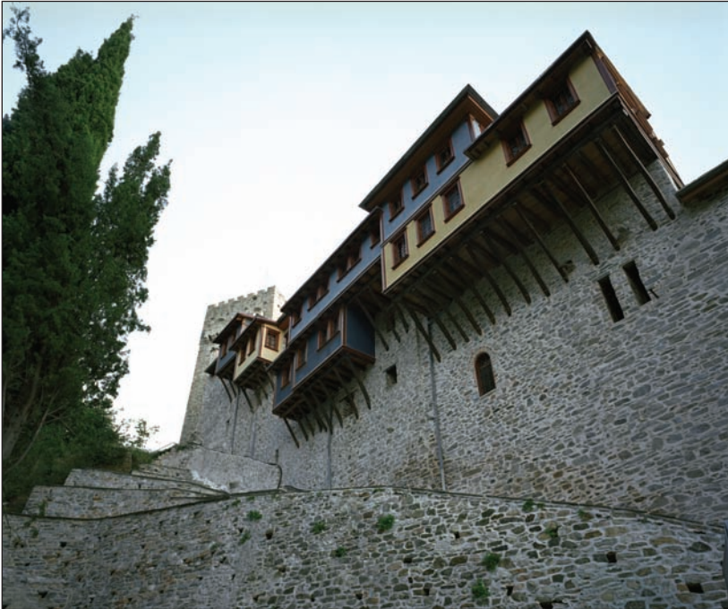
Φωτ.19 Εξωτερική άποψη του ανατολικού τμήματος της βόρειας κόρδας της Ι. Μονής.
