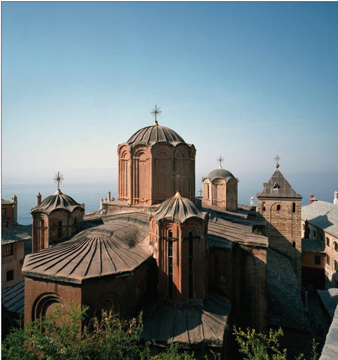
Φωτ.31 Η μολυβδοσκέπαστη κάλυψη του Καθολικού.
