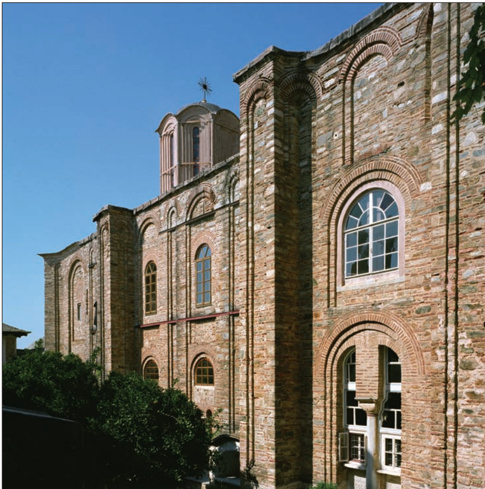
Φωτ.55 Νότια όψη του Καθολικού από την αυλή.
