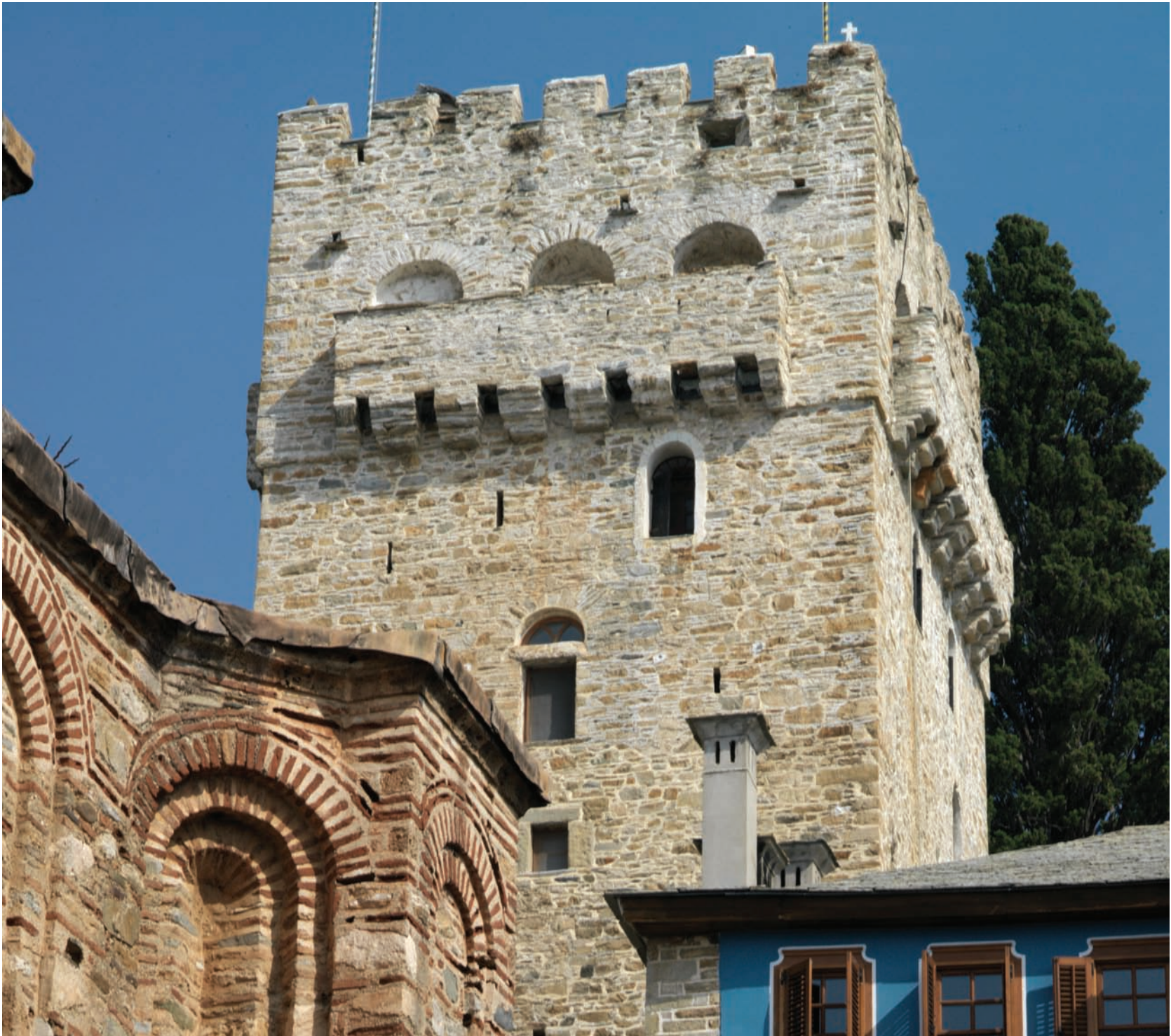
Φωτ.63 Το ανώτερο τμήμα του οχυρωματικού πύργου.
