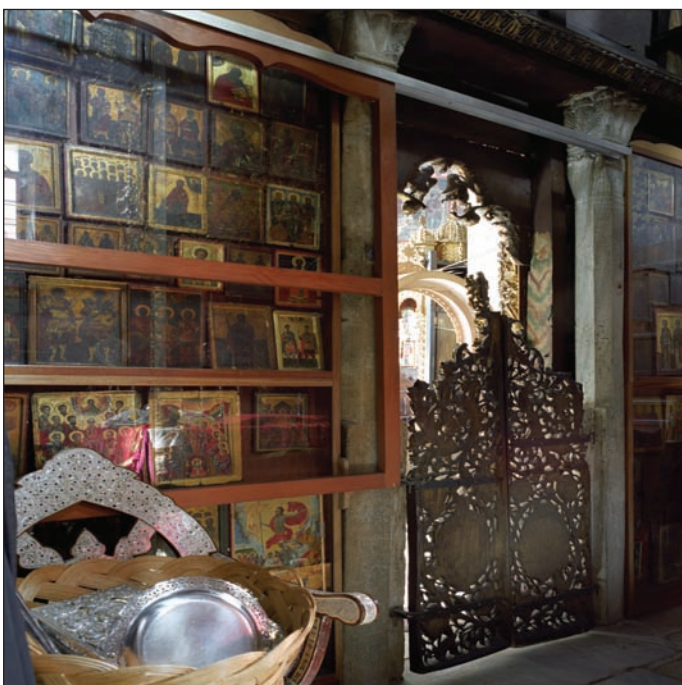
Φωτ.46 Πίσω από το ξυλόγλυπτο τέμπλο φαίνεται ο Β, ως προς την Ωραία Πύλη, μαρμάρινος ορθοστάτης του βυζαντινού τέμπλου. Φωτ.47 Οι δύο μαρμάρινοι πεσίσκοι του βυζαντινού τέμπλου εγκιβωτισμένοι στο νεώτερο ξύλινο.
