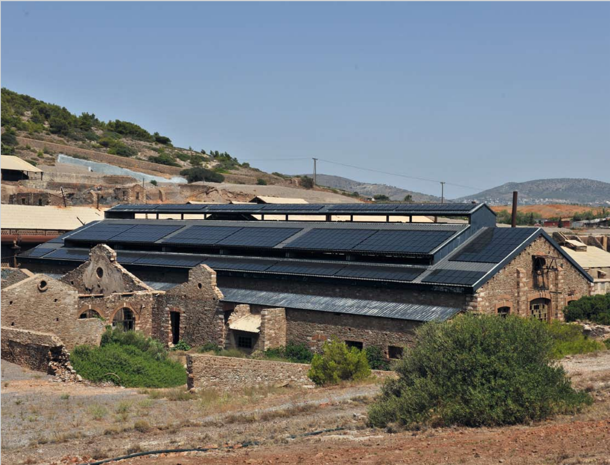
Άποψη του Ηλεκτρικού Σταθμού / View of the Electric Power Station
