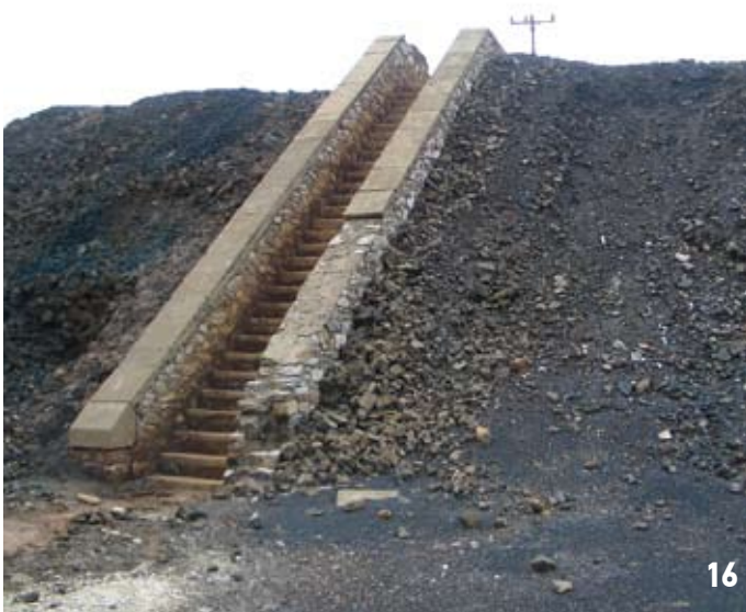
14 Αναλημματικοί τοίχοι για απόθεση υλικών προς περαιτέρω επεξεργασία. Retaining walls for placing materials for further process 15 2010–Κάθοδος προς τον υπόγειο χώρο ταφής τοξικών αποβλήτων. 2010 – Corridor leading to the underground hazardous waste repository. 16 1995-Γενική άποψη εγκαταστάσεων και αναλημματικών τοίχων απόθεσης υλικών. 1995- General view of facilities and retaining walls for the placement of materials.
