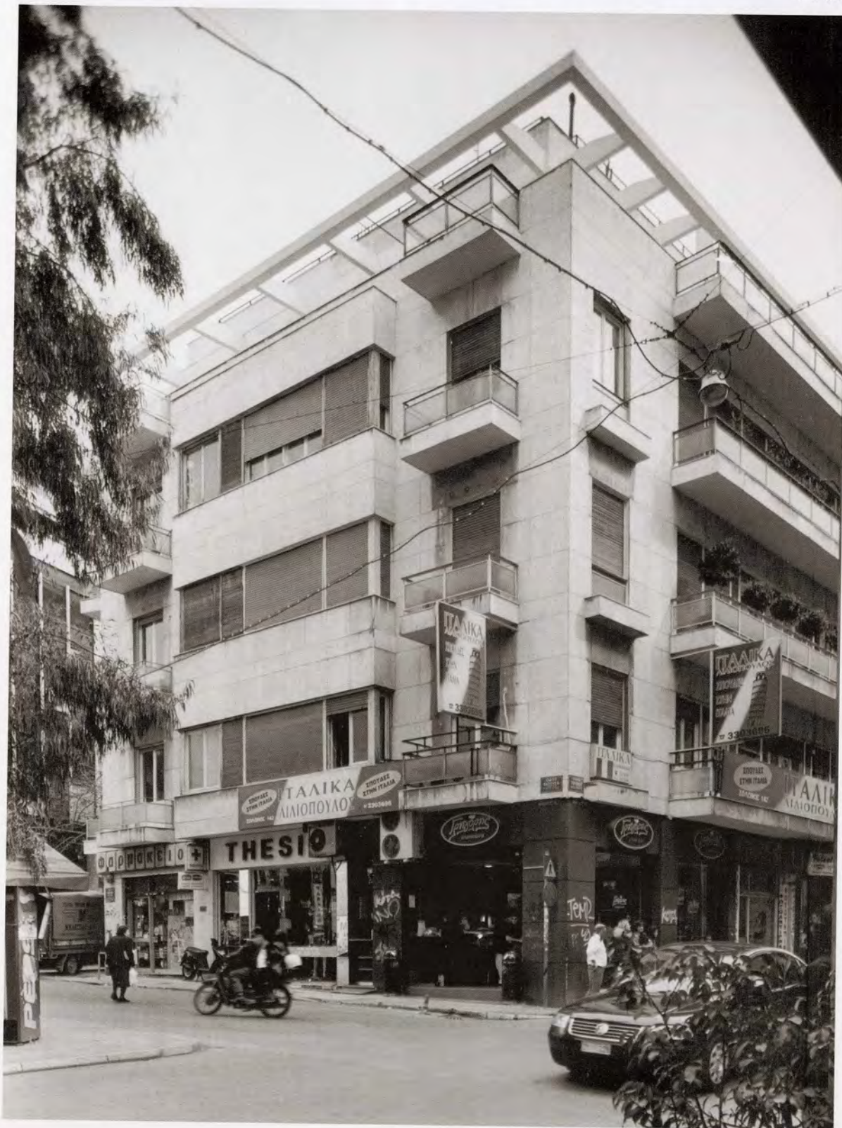
Όψη επί των οδών Κωλέττη και Σόλωνος
