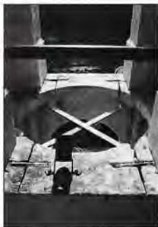
Εικ. 25, 26. Μαρμαρίνες πλάκες στήριξης πεσσών διαζώματος. Πόκατοι εύκαμπτοι-μολυβδοκολλημένοι στη σύνδεση πηλιδιών τεμαχίων μαρμάρου.
