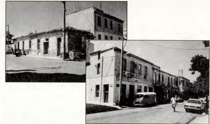
Εικ. 6,7. Στη γειτονιά διατηρούνται πολυώριμα κτίρια που κατασκευάσθηκαν πριν το 1930.
