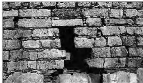
Εικ. 12: Το σημείο υδροδότησης της σταδής. Διακρίνονται οι δύο παραστάδες και οι αυλές που εξέρχονταν το νερό.
