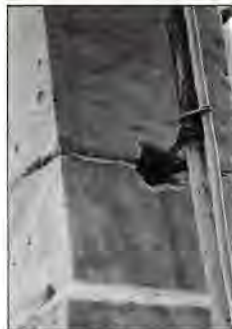
Εικ. 23, 24. α) Αγκυρώσεις απορροφάσεις στη δυτική όψη πεσσών α' και β' διαζώματος στη βορειοδυτική γωνία για τη στήριξη του επεξεκρέταυου. β) Βιοαζόντιες επικαθίσσεις.
