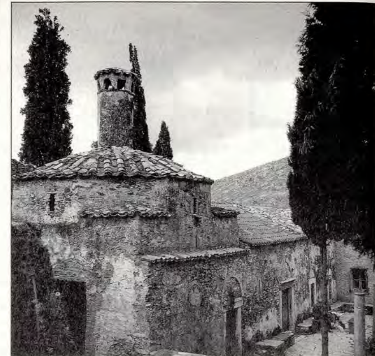
Εικ. 10: Άποψη της πέτρας της Τράπεζας πριν τις εργασίες αποκατάστασης της δεκαετίας του 1950. (Πηγή: Μουσείο Μπενάκη)
