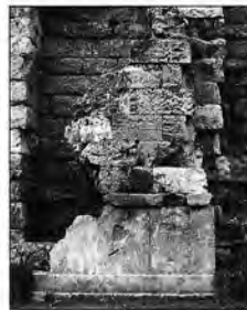
Εικ. 11: Διακρίνεται τμήμα του αρχικού βόρειου τοίχου της σταδής από πίσω. Το τμήμα αυτό είναι από τα λίγα που έχουν διασωθεί. Επίσης διακρίνονται σημάδια από ρίζωση στην επιφάνεια των ορθοστάτων.
