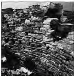
Εικ. 3: Οι δοκοθήκες στον βόρειο εξωτερικό τοίχο.
