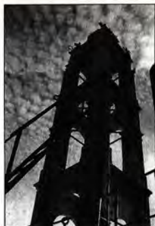
Εικ. 13. Αμείβετες σφαιρίτσες στη Βόρεια και Δυτική όψη. Στήριξη αψιδωφράνου. Στήριξη ειδικών κτισμάτων στους Βορειοδυτικούς πεσσούς στο α' και β' διάγραμμα.
