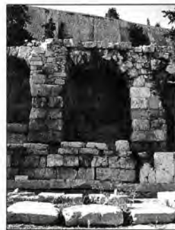
Εικ. 15: Διακρίνεται η ανέγερση της διαμερίσις του βορείου τοίχου της Στάδης μεταξύ των τοξών 1 και 3.
