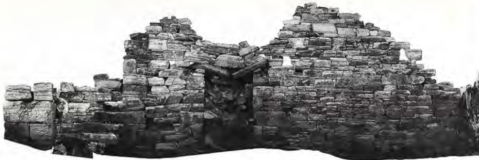
Εικ. 11: Φρυγομακεδό: Βόρεια άψη νότιου εξωτερικού τοίχου.
