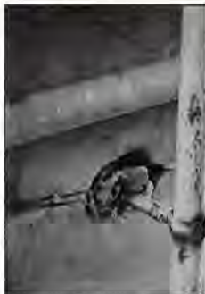
Εικ. 23, 24. α) Αγκυρώσεις απορροφάσεις στη δυτική όψη πεσσών α' και β' διαζώματος στη βορειοδυτική γωνία για τη στήριξη του επεξεκρέταυου. β) Βιοαζόντιες επικαθίσσεις.
