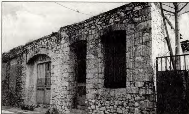
Εικ. 10. Χαρακτηριστικό δείγμα χριστιικού κτιρίου κατασκευασμένου από ηλιδοδομή, επιχρισμένη.
