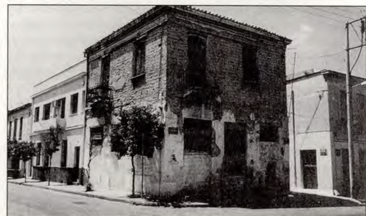
Εικ. 11. Όροφος κτιρίου κατασκευασμένος από οπτόηλιδο.
