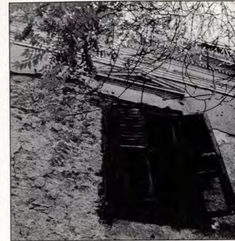
Εικ. 10. Λεπτομέρεια παραδύρου της ανατολικής όψης του κυρίως κτιρίου. Διακρίνεται η αστυματική στέγη από τραβηχτά κονιάματα που είναι και η μοναδική που σώζεται. Νοέμβριος 2001.
