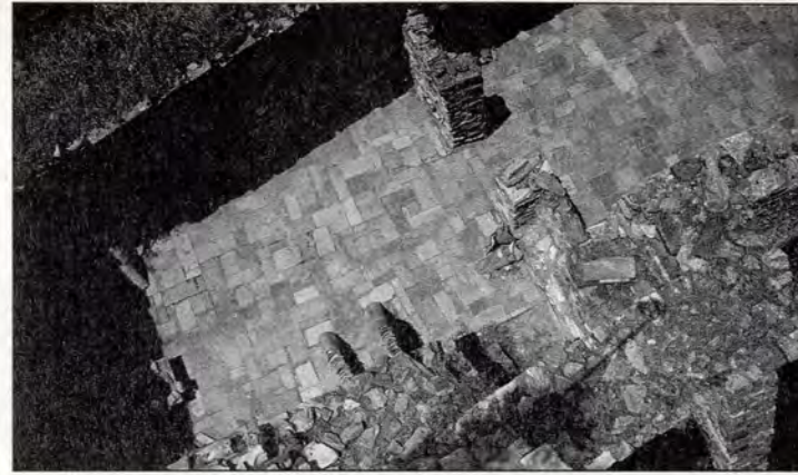
Εικ. 12 Ο κατεστραμμένος όροφος της δυτικής πτέρυγας από ψηλά.
