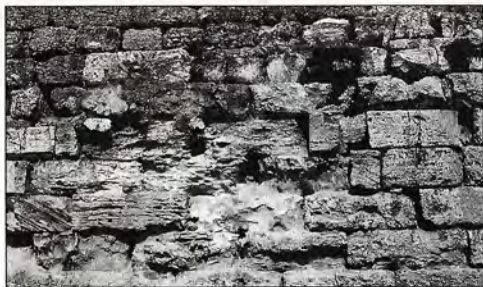
Εικ. 16: Διακρίνεται η αναστροφή του αχνιότη πάρος καθώς και ηχηματισμοί στο ίδιο το υλικό.
