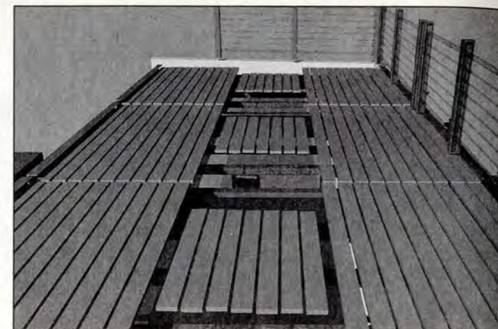
Εικ. 21 Το ξύλινο δάπεδο του δώματος της δυτικής πτέρυγας.
