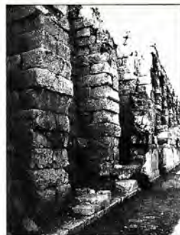
Εικ. 13: Καταστραμμένο τμήμα της τοξοστοικίας. Διακρίνονται οι τετραγώνες απός.
