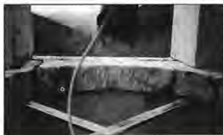
Εικ. 27. Έδραση πεσσών β' διαζώματος.
