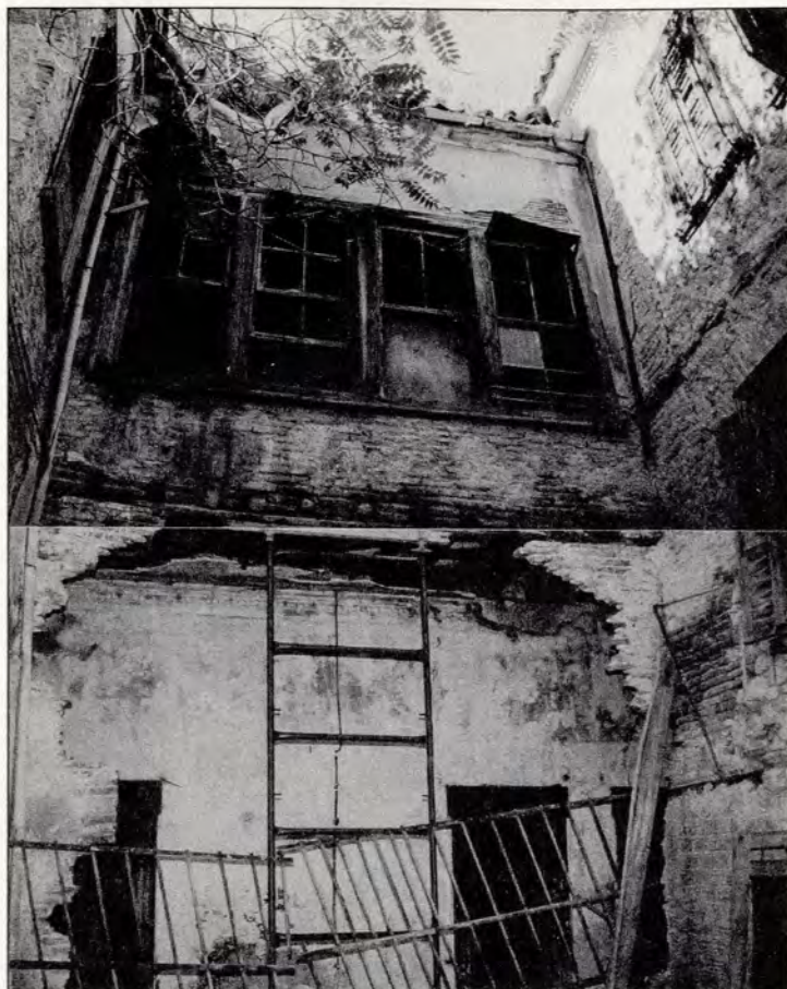
Εικ. 19. Άποψη της ανατολικής όψης. Διακρίνεται η σημαντική κατάρρευση της τοικοποιίας από συμπληγή οπτοπλινθοδομής, κάτω από το χαϊιάτι. Νοέμβριος 2001.
