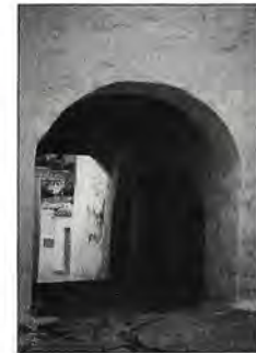
Εικ. 8. Διαβατικό Δ17. Η διάρθρωση του ανατολικού ορίου με τριπλά τόξα.
