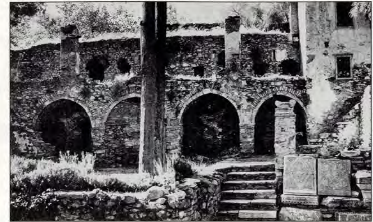
Εικ. 3 Το ανατολικό τμήμα της νότιας πτέρυγας πριν από την αποκατάσταση του 50. (Πηγή: ΦΕΑ)
