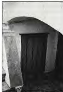
Εικ. 6. Το διαβατικό Δ13, μετά την στέγασή.
