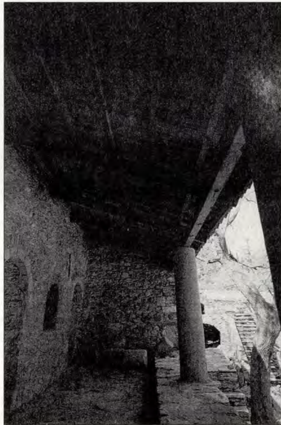
Εικ. 15 Η ξύλινη στέγη στον όροφο του Ανατολικού τμήματος.
