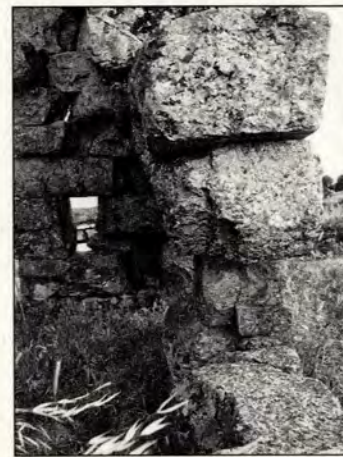
Εικ. 22: Αδύνατες περιοχές στη λιθοδομή.
