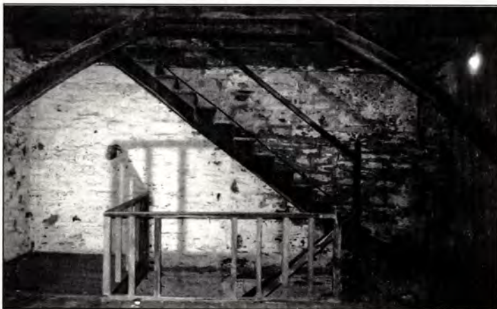
Εικ. 5: Εσωτερική άποψη του 3ου ορόφου. Διακρίνεται το ξύλινο κλιμακοστάσιο.
