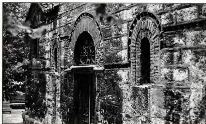
Εικ. 16: Προεξοχή της κατώτερης σειράς δόμων στη νότια όψη.
