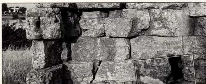
Εικ. 19, 20: Διαμόρφωση πατούρας για την υποδοχή των λίθων εσωτερικής παρειάς.
