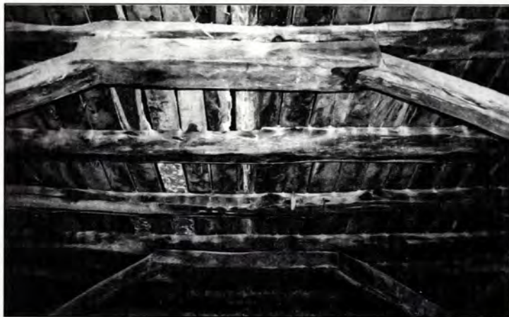
Εικ. 4: Εσωτερική άποψη του 3ου ορόφου. Λεπτομέρεια του ξύλινου, καμπύλου φορέα υποστήριξης του πατώματος.
