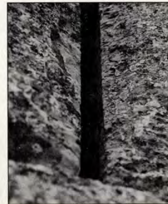
Εικ. 23: Διάνοιξη αρμών ή απομείωση των επιφανειών ύψους.
