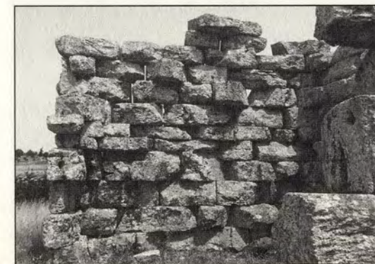
Εικ. 9: Άποψη του εσωτερικού του πύργου.
