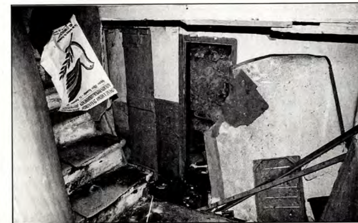
Εικ.12: Πλατύς κλιτος εισόδου από τη Χρ. Κοντού. Άποψη εσωτερικού προς τα Α. Διαχωριστικός εσωτερικός τοίχος από μπαχαρά και λιθοκίστη κλίμακα.
