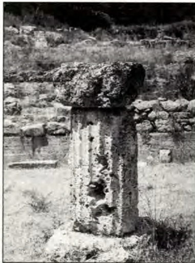
Εικ. 12: Σπόνδυλος και κιονόκρανο της στοάς έντονα διαβρωμένα.
