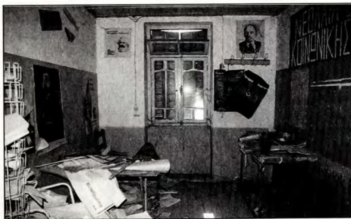
Εικ.10: Άποψη εσωτερικού 1' ορόφου προς τα Α. Τυπικό δωμάτιο ξενοδοχείου από τη μεσοπολεμική οικοδομική φάση του κτιρίου.
