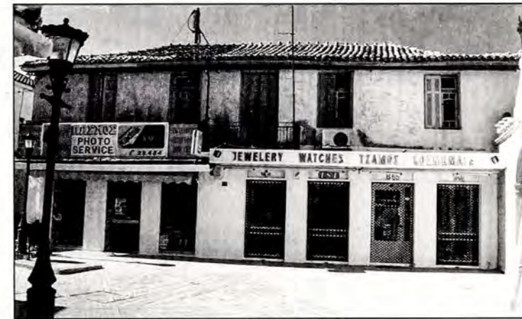
Εικ.6: Άποψη από την οδό Εθνικής Αντιστάσεως. Ανατολική όψη.
