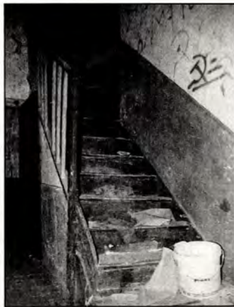
Εικ.16: Ξύλινη κλίμακα προς τον καταδαρισμένο σήμερα β' όροφο.
