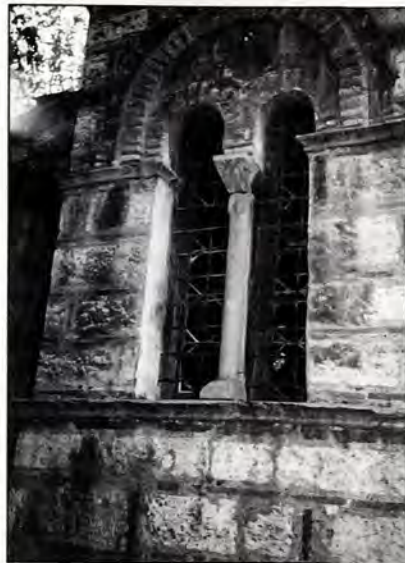
Εικ. 15: Δίτοβο άνοιγμα της κεντρικής αψίδας, διαχωριζόμενο από μαρμάρινο αμφικιονίσκο.
