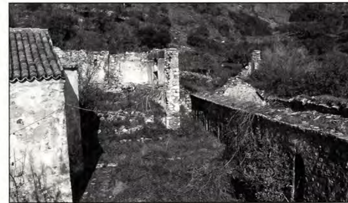
Εικ. 9: Εικόνα εγκατάλειψης από τον περβόλο της Ι. Μ. Ταξιαρχών.
