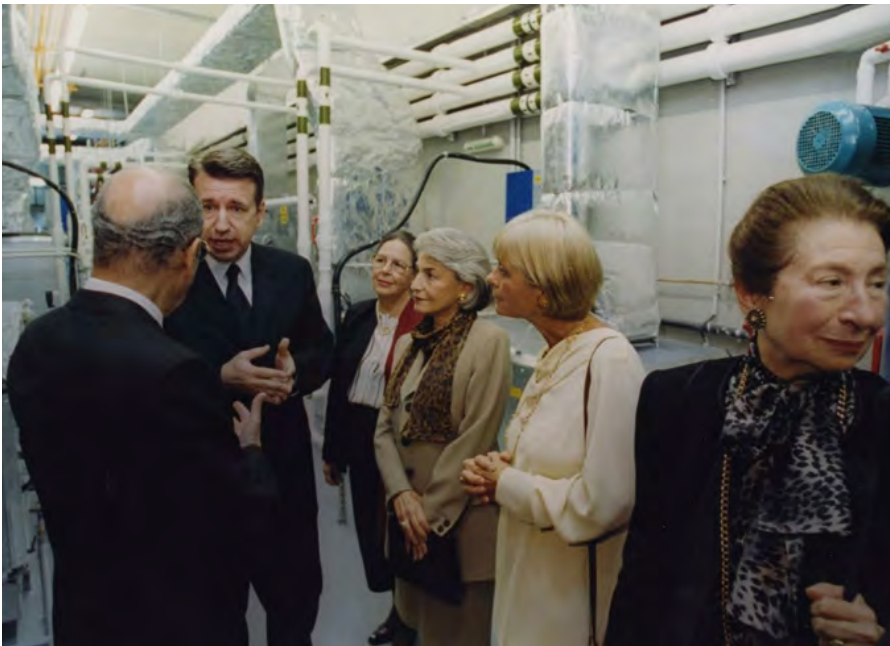
Εικόνα 5: Ξενάγηση στο μηχανοστάσιο της ανακαινισμένης Γενναδειού από τον General Manager της Αμερικανικής Σχολής, Παντελή Πάνο.
