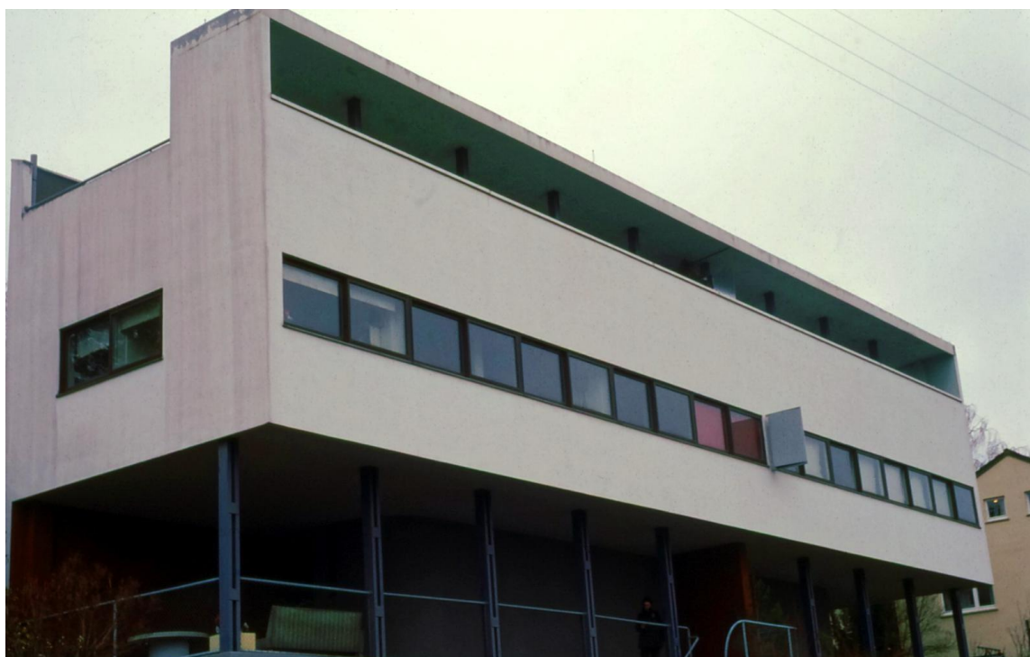
Εικόνα 1.22 Le Corbusier και Pierre Jeanneret, Κτίριο 14-15, κατασκευάστηκε το 1927 στο συγκρότημα κτιρίων του Weissenhof Estate στη Στουτγάρδη της Γερμανίας. Ενσωματώνει όλες τις σχεδιαστικές αρχές της διακήρυξης των «Πέντε Σημείων για μια νέα Αρχιτεκτονική» του Μοντέρνου κινήματος.
