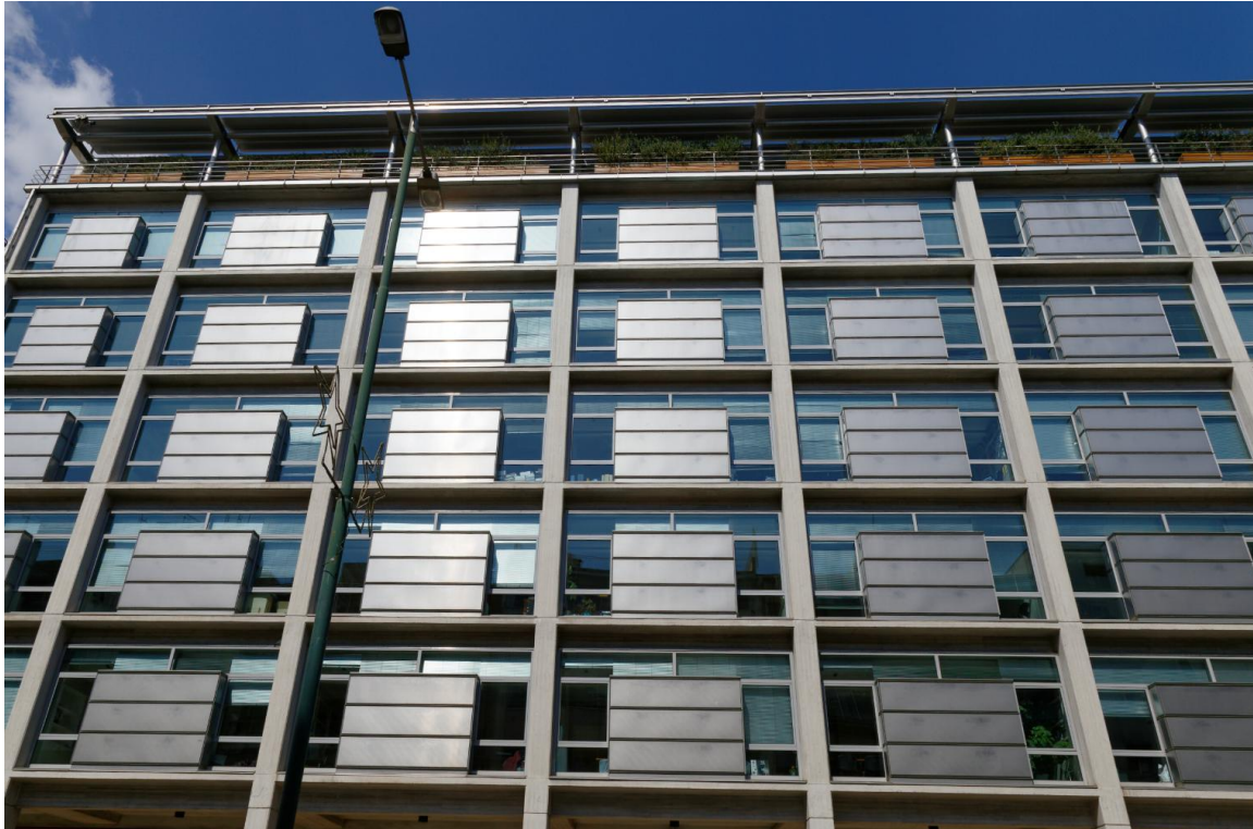
Εικόνα 4.1 Γραφεία της ΓΕΚ. Όψη του κτιρίου με ορατό τον φέροντα οργανισμό από εμφανές σκυρόδεμα και μόρφωση της όψης με υαλοστάσια και ελαφρά πετάσματα με τελική επιφάνεια από φύλλα αλουμινίου. Αρχιτέκτονας Hopkins Architects, στατικά Π. Μαντάς. Λεωφόρος Μεσογείων, Αθήνα, 2002.
