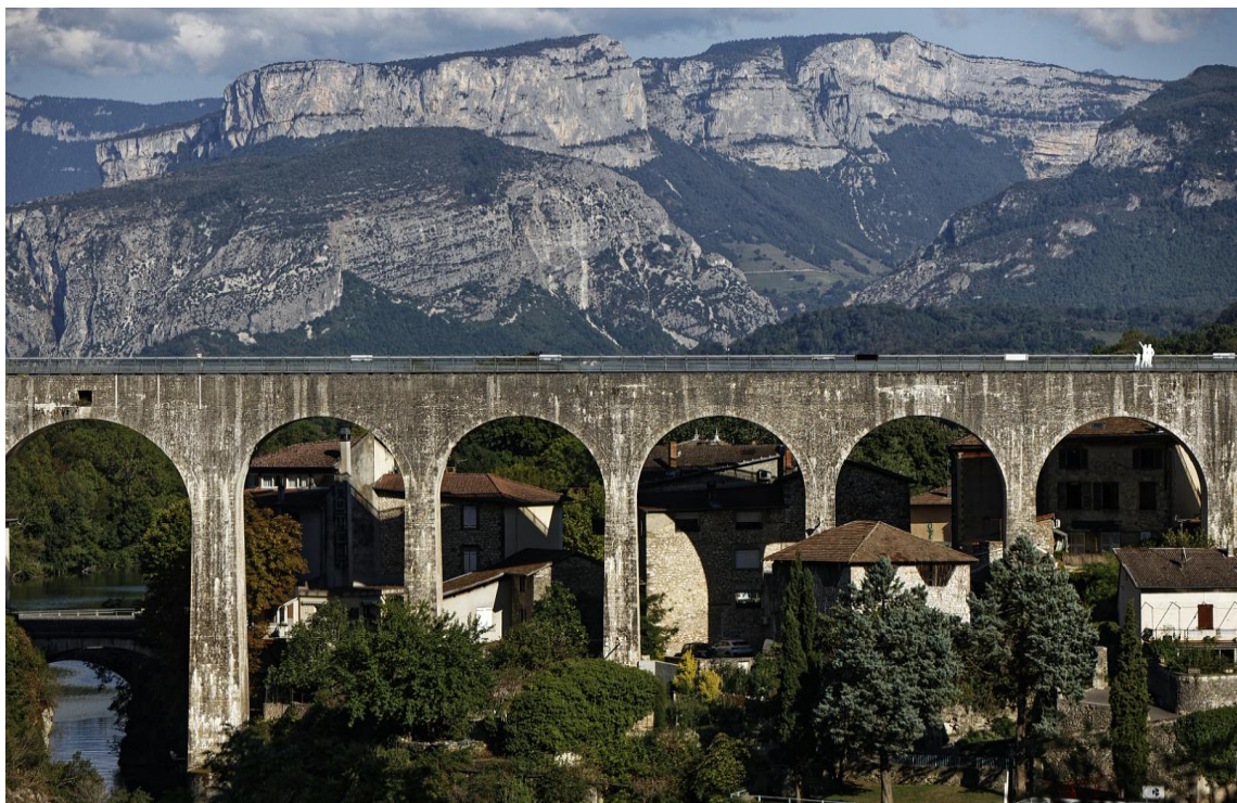
Εικόνα 1.19 Υδραγωγείο στον ποταμό Isère από λίθινες τοξοστοιχίες. Saint-Nazaire-en-Royans, Γαλλία.
