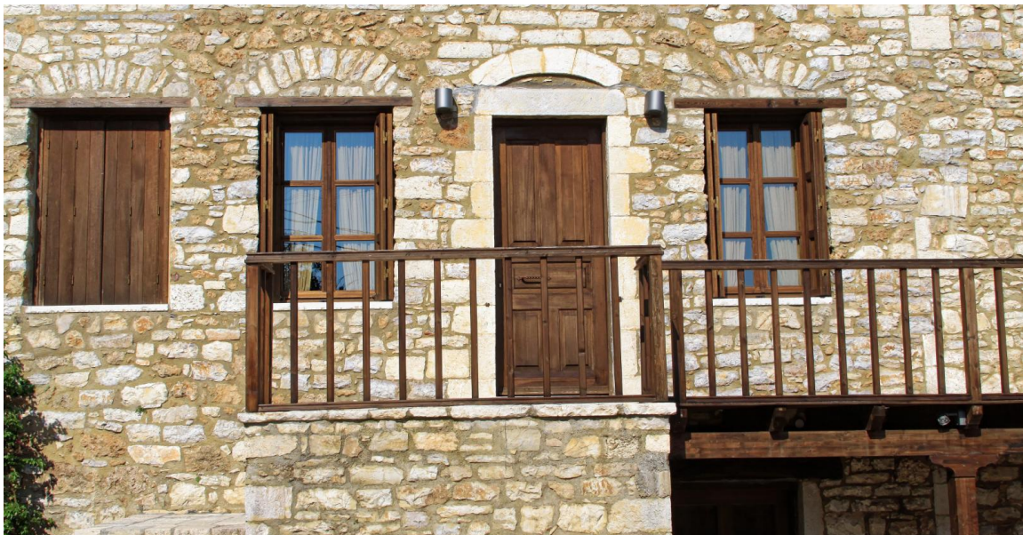
Εικόνα 6.1 Κτίριο με φέρουσα λιθοδομή. Αποκατάσταση διατηρητέου κτιρίου. Αρχιτέκτονας Π. Βασιλάτος, Νέα Φιγαλία Ν. Ηλείας 2010.
