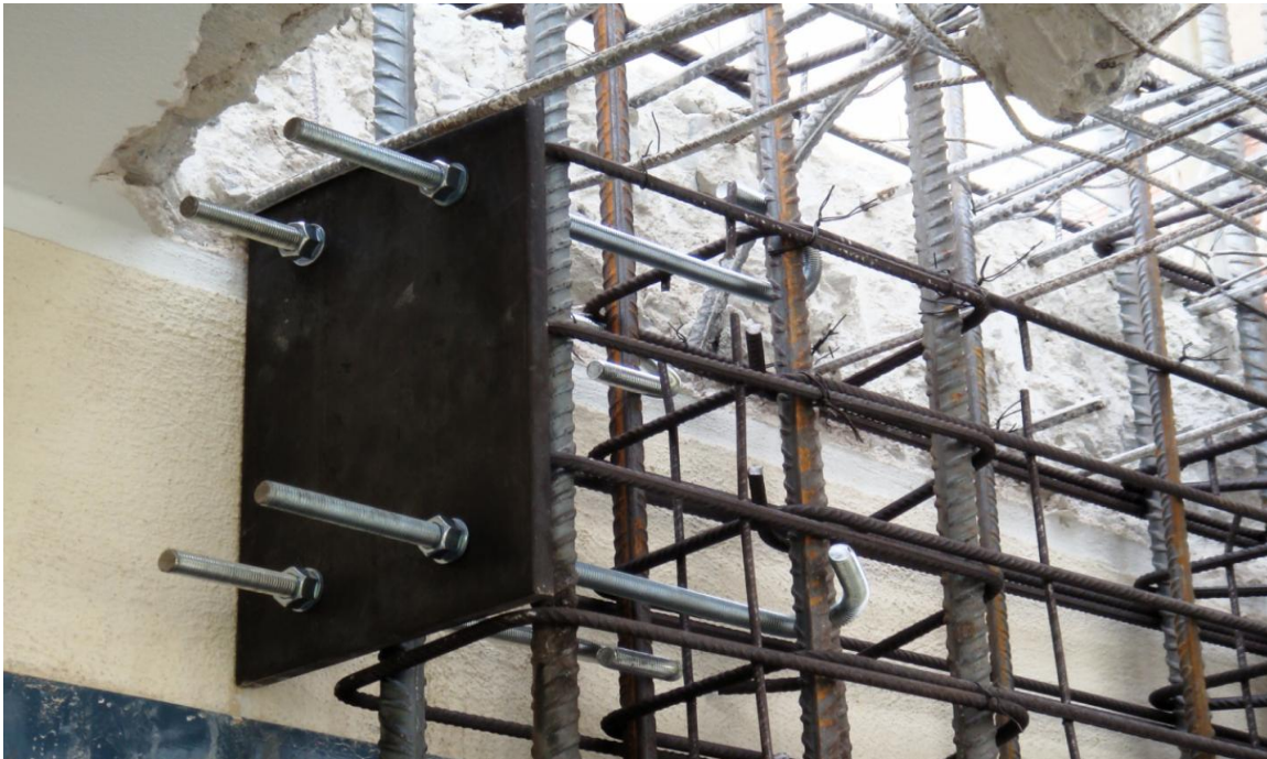
Εικόνα 6.79 Συνδέσεις μεταλλικών στοιχείων με στοιχεία οπλισμένου σκυροδέματος.
