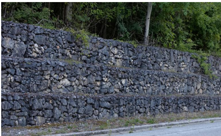
Εικόνα 3.47 Συρματοκιβώτια για την αντιστήριξη πρανών. Στην κατασκευή τους χρησιμοποιήθηκαν τοπικοί λίθοι.
