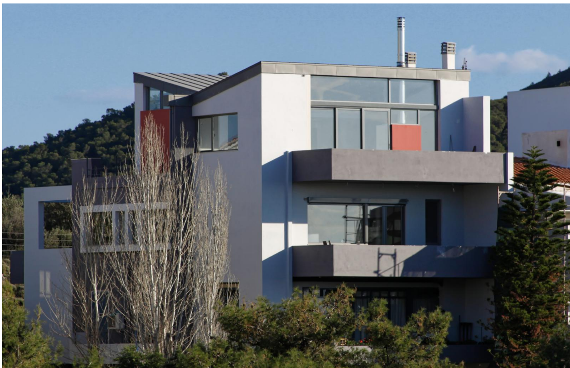
Εικόνα 4.4 Κτίριο κατοικίας στη Βούλα. Σύμμεικτη κατασκευή του τελευταίου ορόφου για ελάττωση φορτίων με τη χρήση υποστυλωμάτων σκυροδέματος και μεταλλικών δοκών. Κάλυψη με φύλλα τιτανιούχου ψευδάργυρου.
