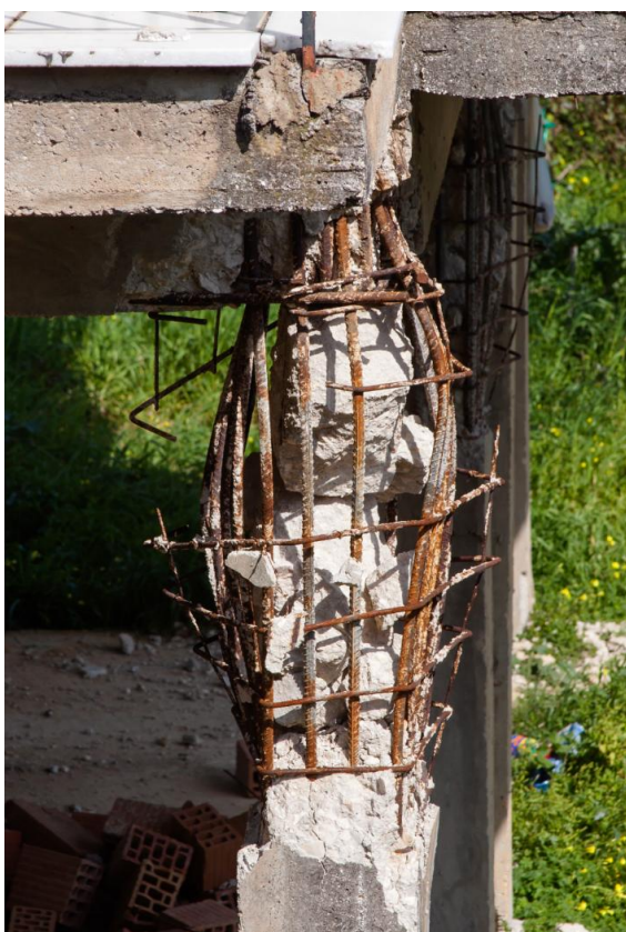
Εικόνες 1.37, 1.38 Παραδείγματα θλάθης κτιρίων από το τον σεισμό στην Κεφαλονιά το 2014. Αριστερά υποστυλώμα δώροφου κτιρίου κατοικίας με riotis στο Ληξούρι και δεξιά «κόψιμο» υποστυλώματος στο ισόγειο διώροφου κτιρίου στο Αργοστόλι.
