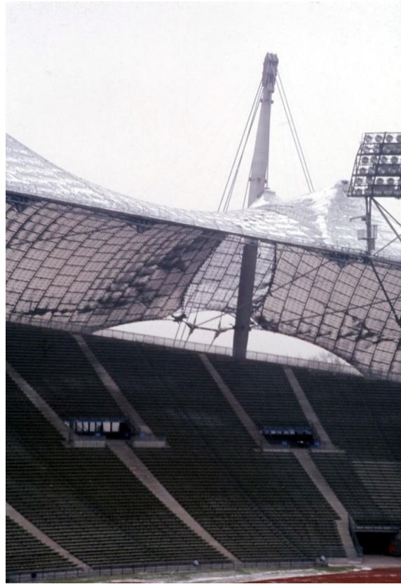
Εικόνες 1.27, 1.28 Στέγαση του Ολυμπιακού σταδίου στο Μόναχο. Εφελκόμενη κατασκευή με δίχτυα διπλής καμπυλότητας από συρματοσχοίνα. Αρχιτέκτονες Günther Behnisch και Frei Otto, με συνεργάτη στην επίλυση πεπερασμένων στοιχείων τον Ι. Χατζηαργύρη. Μόναχο, Γερμανία, 1972.
