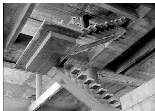
Εικόνες 3.33, 3.34, 3.35, 3.36 Διακρίνονται χαρακτηριστικά οι ράμπες και η σκάλα, όλα σε μορφή ελεύθερου προβόλου που εδράζονται σε δύο επίπεδα με ελεύθερο αιωρούμενο άκρο.
