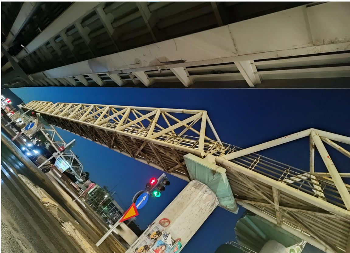
Εικόνα 3.15 Δικτυωματική πεζογέφυρα στη διασταύρωση της Λεωφόρου Καβάλας με την Ε.Ο. Ο φορέας αποτελείται από χαλύβδινες κυκλικές ηλεκτροσυγκολλημένες διατομές. Το άνοιγμα μεταξύ των πυλώνων είναι 52,0 m.
