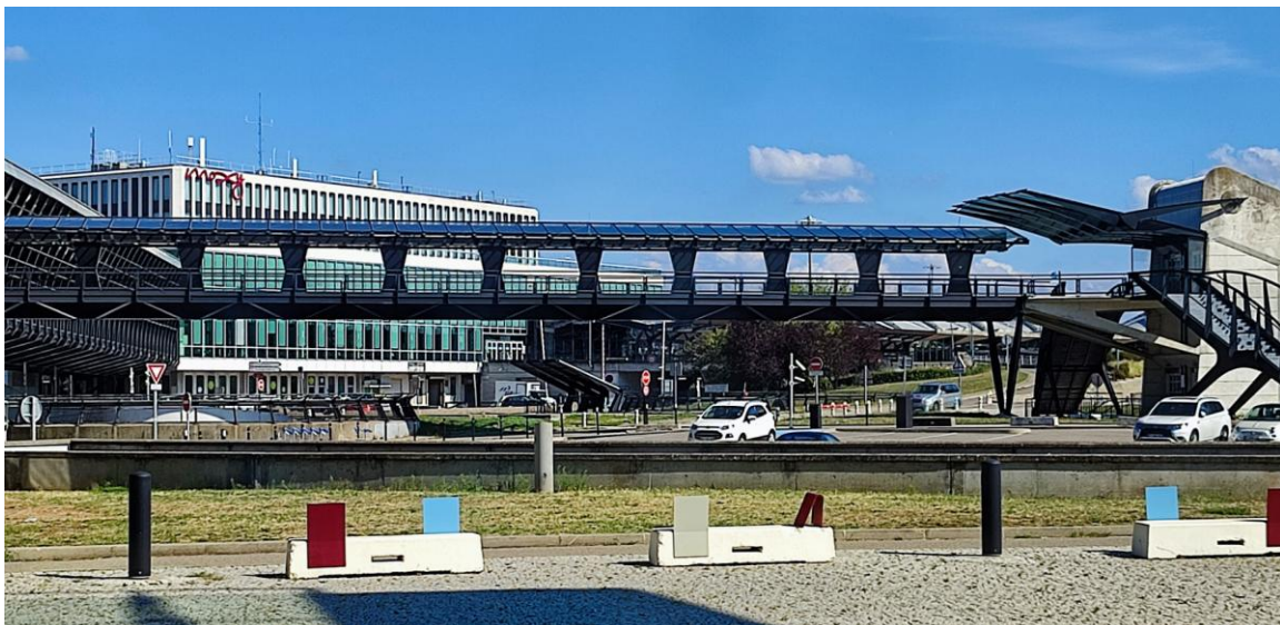
Εικόνα 2.36 Μεταλλική πεζογέφυρα Vierendeel στο αεροδρόμιο της Λυών. Είναι χαρακτηριστική η μορφή του διατμητικού δικτύωματος με τα κατακόρυφα στοιχεία, που είναι ενισχυμένα και, άρα, φαρδύτερα στις στηρίξεις. Αρχιτέκτονας Santiago Calatrava.
