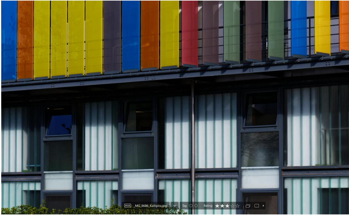
Εικόνα 6.22 Κτίριο γραφείων στη Λεωφόρο Συγγρού. Διαμόρφωση όψης ισογείου με σύνθετα υαλοπετάσματα από σταθερά και ανοιγόμενα παράθυρα και ενδιάμεσους υαλότοιχους. Στον όροφο, επιδερμίδα κρεμαστή σε απόσταση από κατακόρυφες περιστρεφόμενες περσίδες για τον έλεγχο του φωτός. Υλικό περσίδων έγχρωμο γυαλί ασφαλείας.
