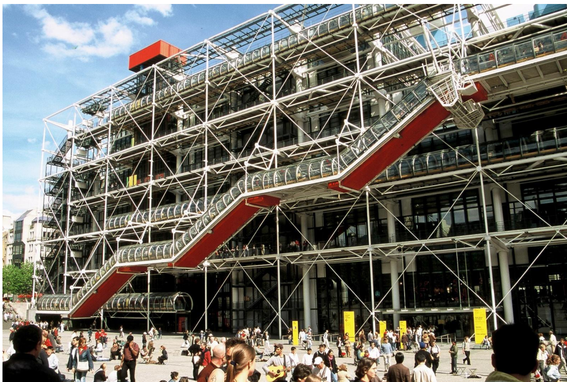
Εικόνα 1.29 Κέντρο Πολιτισμού «Georges Pompidou», αρχιτέκτονες Renzo Piano, Richard Rogers και Gianfranco Franchini, στατικά Arup, Παρίσι 1977. Δυτική όψη από την κεκλιμένη πλατεία εισόδου στο κτίριο.
