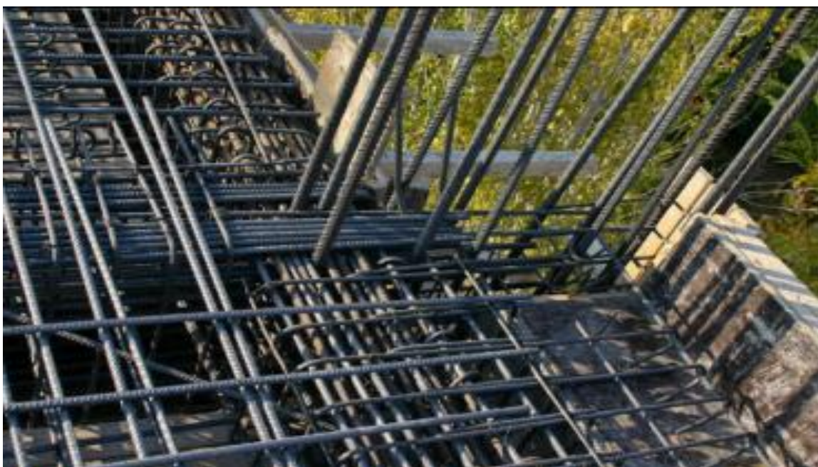
Εικόνα 3.29 Σημείο συμβολής χαλύβδινου σπλισμού δοκών με το υποστυλωμα σε φορέα από σκυρόδεμα.
