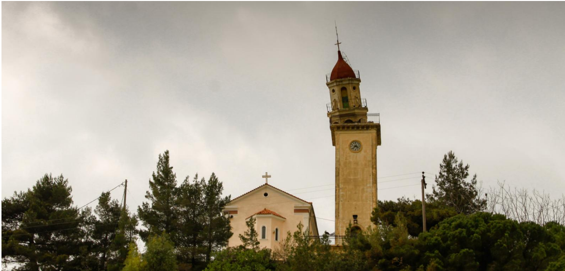
Εικόνα 1.39 Παραδείγματα βλάβης κτιρίων από το τον σεισμό στην Κεφαλονιά το 2014. Το κορύφωμα του καμπαναριού στο χωριό Κουρουκλάτα μετά από τους σεισμούς του 1953 είχε αποκατασταθεί με ασύμβατα υλικά. Η τετράγωνη βάση παρέμεινε λίθινη ενώ το οκταγωνικό κορύφωμα ανακατασκευάστηκε από σκυρόδεμα.
