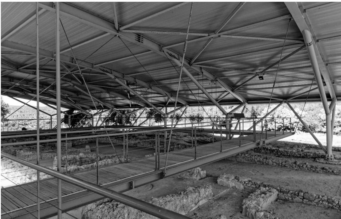
Εικόνα 3.12 Τοξωτό μεταλλικό στέγαστρο ανοίγματος 50,0 m, με μεταλλικούς διαδρόμους κυκλοφορίας επισκεπτών. Αναρτημένους από μεταλλικές ράβδους μέσω αρθρώσεων. Το στέγαστρο καλύπτει τον χώρο ανασκαφών στο «Παλάτι του Νέστορα» στην Πύλο. Έργο του Υπουργείου Πολιτισμού που ολοκληρώθηκε το 2016.
