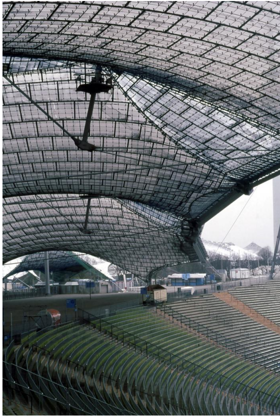
Εικόνες 1.27, 1.28 Στέγαση του Ολυμπιακού σταδίου στο Μόναχο. Εφελκόμενη κατασκευή με δίχτυα διπλής καμπυλότητας από συρματοσχοίνα. Αρχιτέκτονες Günther Behnisch και Frei Otto, με συνεργάτη στην επίλυση πεπερασμένων στοιχείων τον Ι. Χατζηαργύρη. Μόναχο, Γερμανία, 1972.
