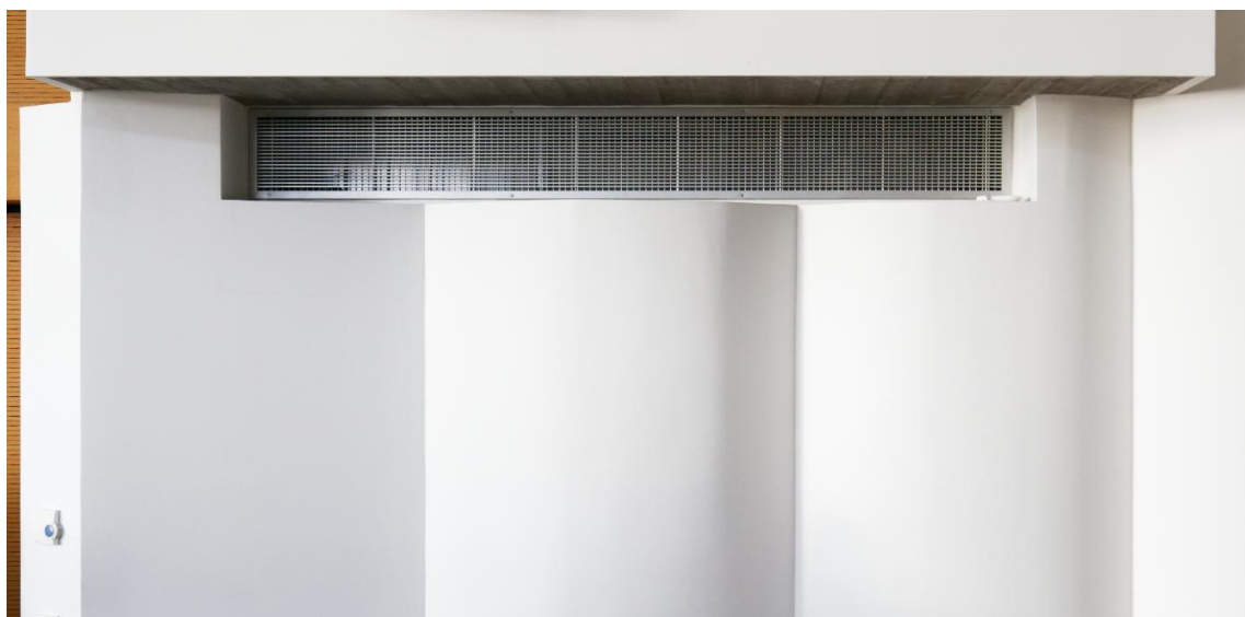
Εικόνα 6.89 Ακουστική ηχοανακλαστική καμπύλη διάταξη στο αμφιθέατρο του κτιρίου ΤΣΜΕΔΕ. Αρχιτέκτονες ΟΜ Μελετητική, Α. Δημοπούλου, Κ. Σαΐτη, Γ. Σταθόπουλος, Α. Χριστοδουλέα, στατικά Ε. Γιαννουλάκης. Αθήνα 2013.
