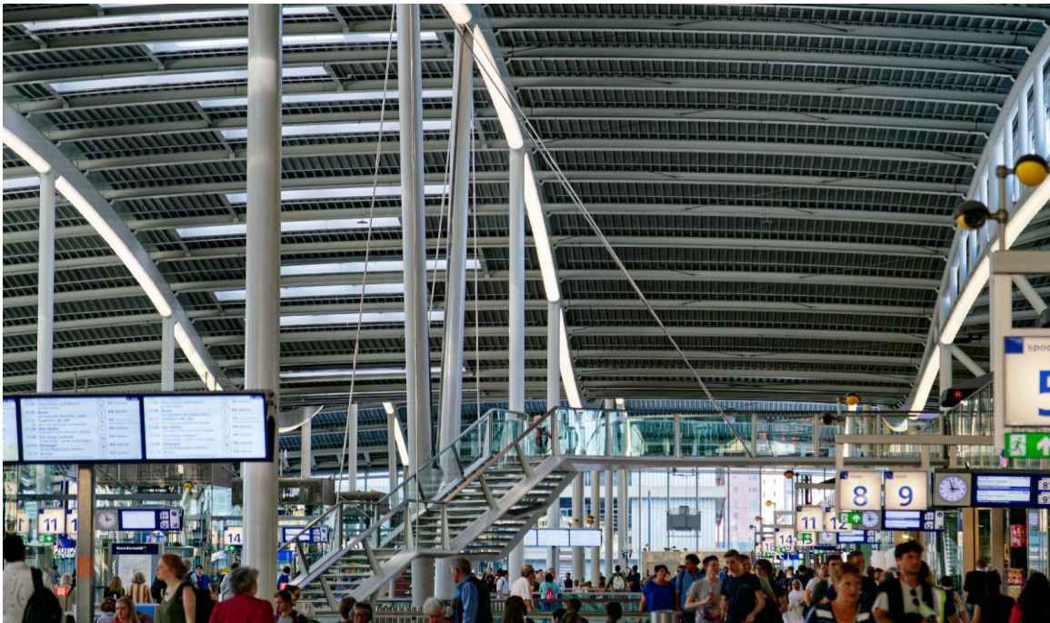
Εικόνα 3.11 Σιδηροδρομικός σταθμός στο Άρνεμ της Ολλανδίας. Κατασκευή με καμπύλες δοκούς και υποστυλώματα. Ελαφρά κάλυψη με τραπεζοειδή λαμαρίνα, θερμομόνωση και φύλλα μετάλλου. Τα υποστυλώματα και οι κύριες δοκοί του φορέα έχουν στρογγυλές κοίλες διατομές, ενώ οι τεγίδες έχουν μεταλλικές διατομές μορφής διπλού «Τ». Ο διάδρομος κυκλοφορίας και η σκάλα αναρτώνται από τον φορέα της στέγης με χαλύβδινες ράβδους ελκυστήρων.
