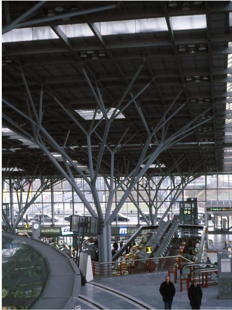
Εικόνα 2.18 Επιβατικός σταθμός 1 του αερολιμένα της Στουτγάρδης. Η επίπεδη ελαφρά κεκλιμένη στέγη στηρίζεται σε χαρακτηριστικά μεταλλικά δενδρόσχημα υποστυλώματα. Αρχιτέκτονες, M. von Gerkan, K. Brauer. Στουτγάρδη, Γερμανία 1991.
