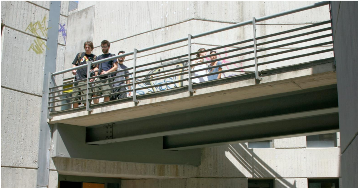
Εικόνα 6.81 Σύμμεικτη κατασκευή πεζογέφυρας με δοκούς από χαλύβδινες διατομές διπλού «Τ» στο νέο κτίριο βιβλιοθήκης του Αριστοτέλειου Πανεπιστήμιου Θεσσαλονίκης. Αρχιτέκτονας Α. Κωτσιώπουλος, Μ. Παπανικολάου και Ρ. Σακελλαρίδου. Θεσσαλονίκη 2000.
