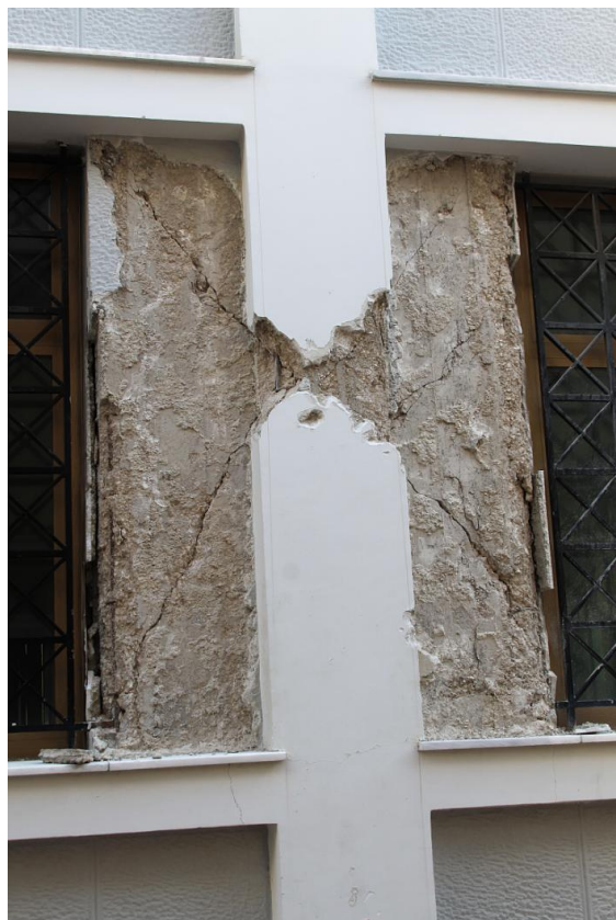
Εικόνες 1.37, 1.38 Παραδείγματα θλάθης κτιρίων από το τον σεισμό στην Κεφαλονιά το 2014. Αριστερά υποστυλώμα δώροφου κτιρίου κατοικίας με riotis στο Ληξούρι και δεξιά «κόψιμο» υποστυλώματος στο ισόγειο διώροφου κτιρίου στο Αργοστόλι.
