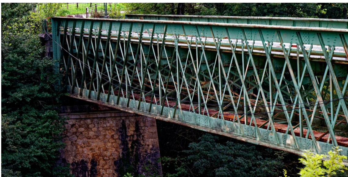
Εικόνα 1.18 Saint-Laurent-en-Royans, Γαλλία. Μικρή σιδερένια γέφυρα με μορφή φορέα της πρώιμης Βιομηχανικής εποχής από μεταλλικά καρφωτά δικτυώματα, των οποίων οι ράβδοι διασταυρώνονται.
