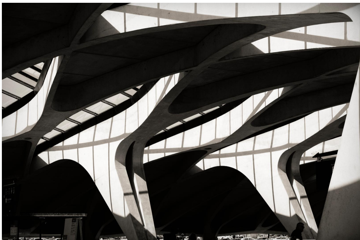
Εικόνα 5.4 Προκατασκευασμένα επαναλαμβανόμενα στοιχεία οπλισμένου σκυροδέματος στον σταθμό TGV της Λυών. Αρχιτέκτονας S. Calatrava, Λυών, Γαλλία 1994.
