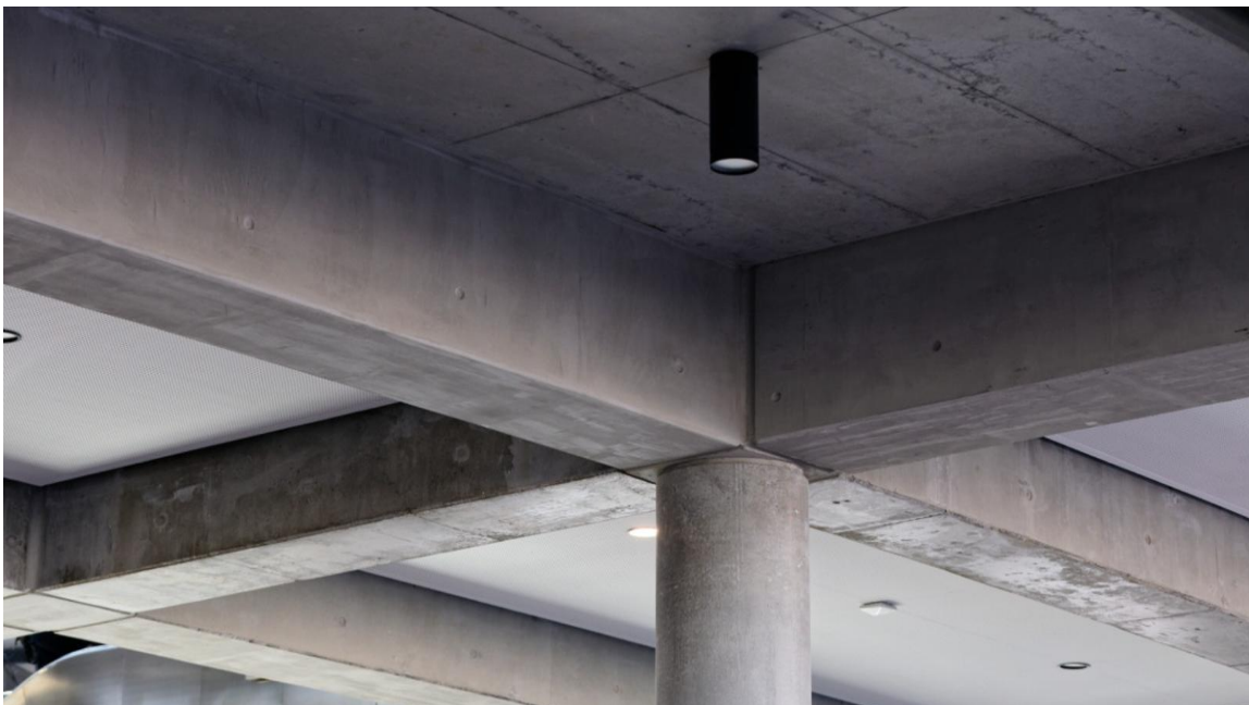
Εικόνα 3.23 Διασταύρωση δοκών με στρογγυλό υποστυλώμα. Ο φορέας από εμφανές οπλισμένο σκυρόδεμα. Στις δοκούς διακρίνονται τα ίχνη των μεταλλότυπων με τις χαρακτηριστικές οπές.
