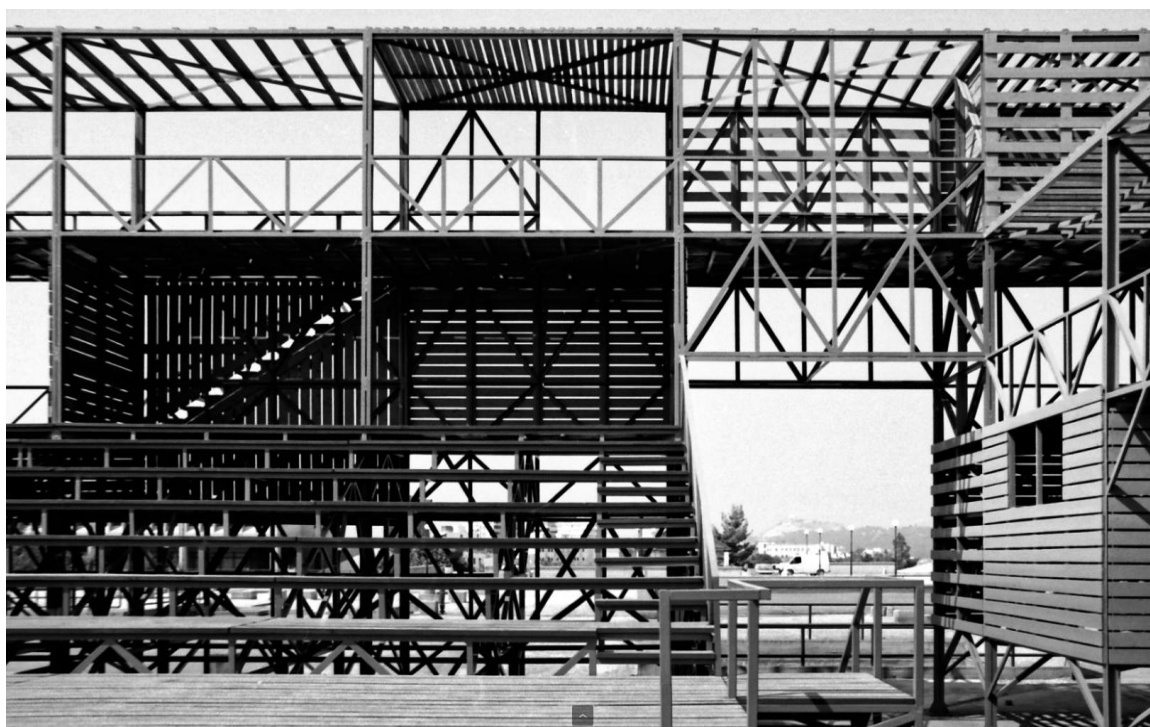
Εικόνα 8.1 Υπαίθριο θέατρο με φέροντα οργανισμό από ελαφρά επίπεδα δικτυώματα από ανοικτές διατομές χάλυβα και επένδυση με σανίδες φυσικής ξυλείας. Αρχιτέκτονας Δημήτρης Μπίρης και ειδικός συνεργάτης αρχιτέκτονας Δημήτρης Παπαλεξόπουλος. Πολυτεχνειούπολη Ζωγράφου, 1997.
