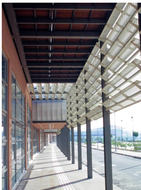
Εικόνες 4.30, 4.31 Κέντρο τύπου στο Στάδιο Τάε-Κβον-Ντο στο Παλαιό Φάληρο. Διάτρητες σταθερές μεταλλικές περσίδες σκίασης στην όψη του κτιρίου. Αρχιτέκτονας Θ. Παταγιάννης και συνεργάτες, Πειραιάς 2004.
