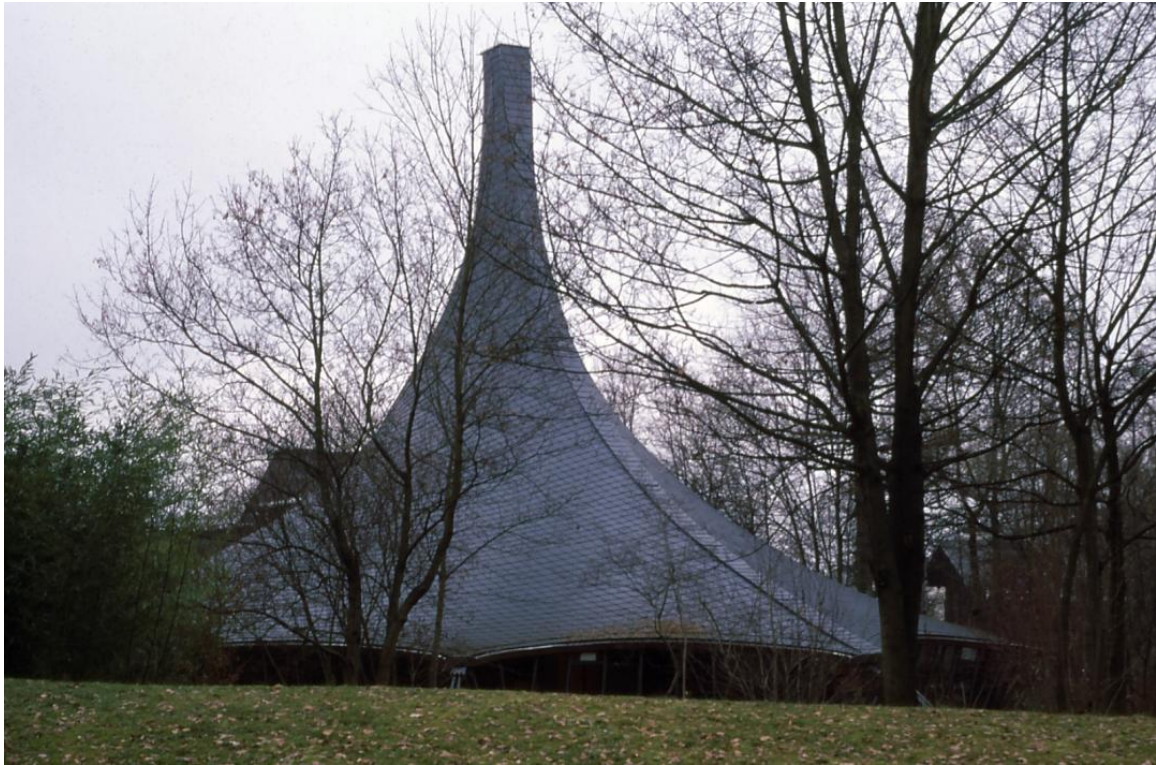
Εικόνα 2.31 Άποψη του Εργαστηρίου Ελαφρών Κατασκευών «IL» (Institut für Leichte Flächentragwerke) που ίδρυσε ο Frei Otto στο Πανεπιστήμιο της Στουτγάρδης. Η τεράστια πειραματική στέγη είναι από εφελκυσμένο δίκτυο καλωδίων, που υποβαστάζονται από έναν μεταλλικό ιστό στο κέντρο. Ακαμπττοποιείται με περιμετρική προένταση και αγκύρωση στο έδαφος. Η κάλυψη γίνεται με ξύλινα καδρόνια, σανίδωμα και τελική επένδυση με διπλωμένες μεταξύ τους φολίδες τιτανιούχου ψευδαργύρου. Στουτγάρδη, Γερμανία, 1968.
