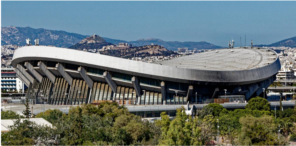
Εικόνα 2.30 Στάδιο «Ειρήνης και Φιλίας» χωρητικότητας 11.000 θέσεων. Η στέγαση γίνεται με περιμετρικό θλιβόμενο δακτύλιο από οπλισμένο σκυρόδεμα, κιβωτιοειδούς διατομής, σε σχήμα σέλας, διαστάσεων 5,5x8,0 m και διαμέτρου 114,0 m. Ο δακτύλιος εδράζεται σε ακτινωτά διατεταγμένους νομείς από σκυρόδεμα που φέρουν επίσης και τις κερκίδες του σταδίου. Το άνοιγμα γεφυρώνεται με διασταυρούμενα καλώδια διπλής καμπυλότητας, διαμέτρου 60 mm και 46 mm σε κάρναβο 4,0x4,0 m. Αρχιτέκτονας Θ. Παπαγιάννης και συνεργάτες, στατικά Δ. Μπαϊρακτάρης. Πειραιάς, 1984.
