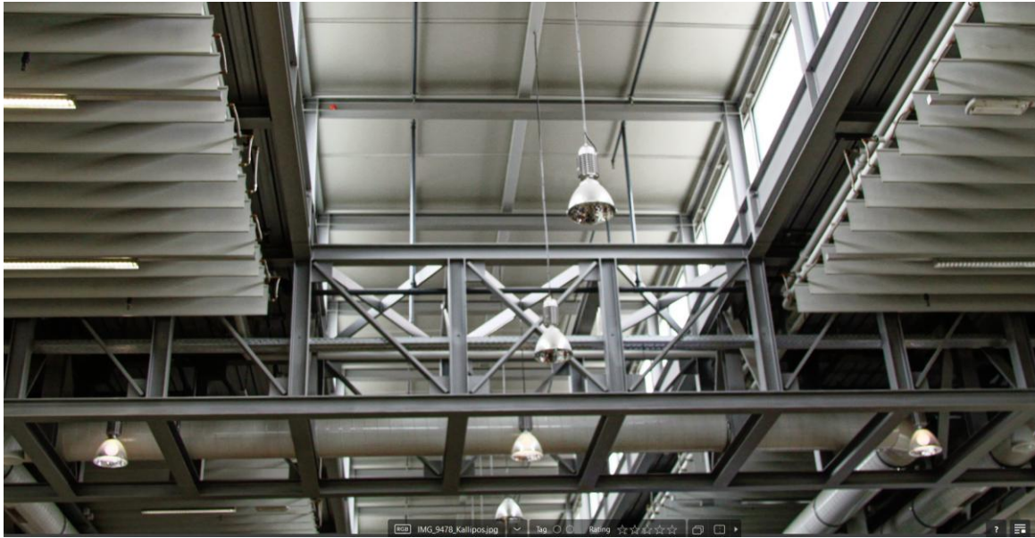
Εικόνα 2.37 Δικτύωμα στέγης που διαιρείται σε μονό αριθμό τομέων με το χαρακτηριστικό «Χ» στον μεσαίο τομέα. Από την επέκταση των ράβδων στους κόμβους καθ' ύψος, στηρίζεται υπερωψωμένο πλαίσιο που δημιουργεί γραμμικό φωτιστικό φεγγίτη. Επιβατικός σταθμός αερολιμένα Γενεύης.
