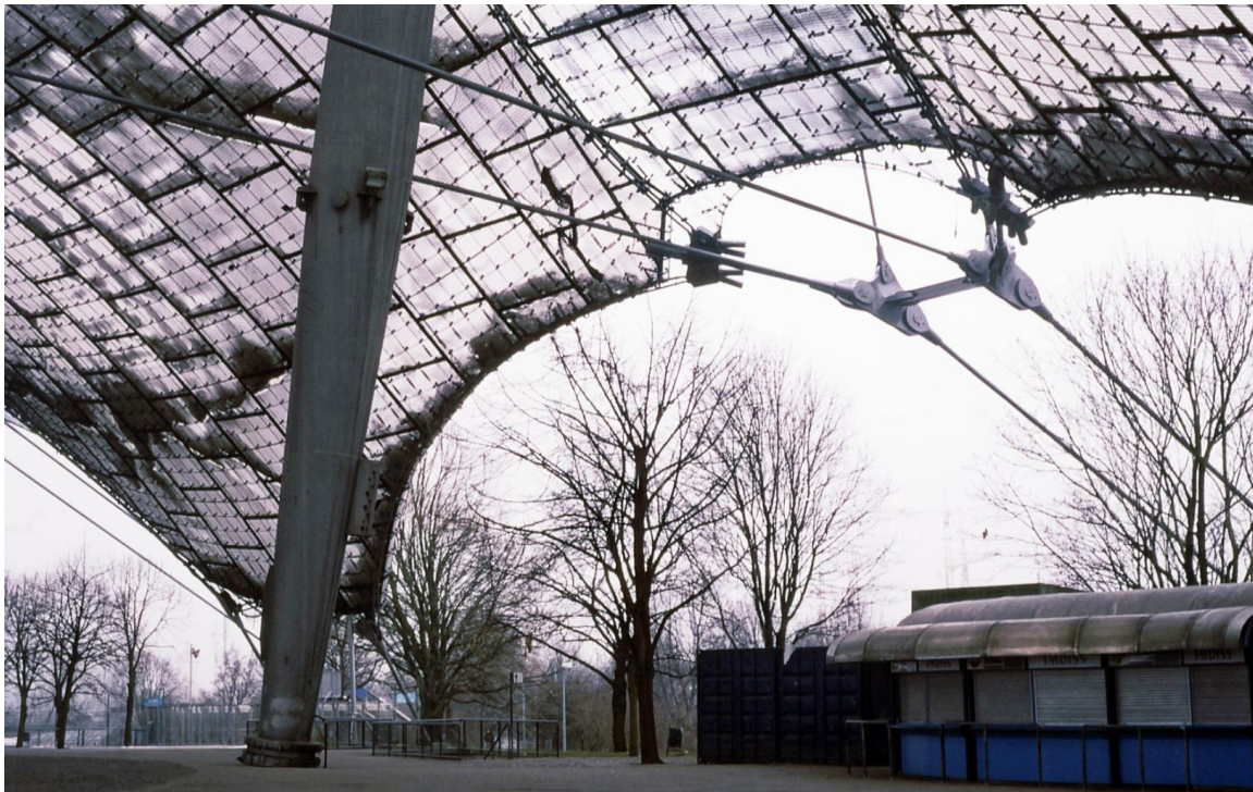
Εικόνα 6.70 Βάση μεταλλικού ιστού που υποβαστάζει το δίχτυ για την κάλυψη του Ολυμπιακού Σταδίου στο Μόναχο. Το δίχτυ αγκυρώνεται και προεντείνεται περιμετρικά, ώστε να παραμένει άκαμπτο. Μεταξύ των βρόγχων στερεώνονται με βίδες τετράγωνα διαφανή φύλλα από ακρυλικό κρύσταλλο. Αρχιτέκτονες Günther Behnisch και Frei Otto, με συνεργάτη στην επίλυση πεπερασμένων στοιχείων τον I. Χατζηαργύρη. Μόναχο, Γερμανία, 1972.
