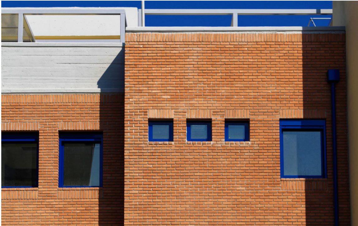
Εικόνα 4.9 Όψη από συμπαγή τούβλα αναρτημένα στον φέροντα οργανισμό από οπλισμένο σκυρόδεμα. Βρεφονηπιακός σταθμός στο Ίλιον. Αρχιτεκτονικά Ε. Αγριαντώνη, Π. Βασιλάτος, Ίλιον 2007.
