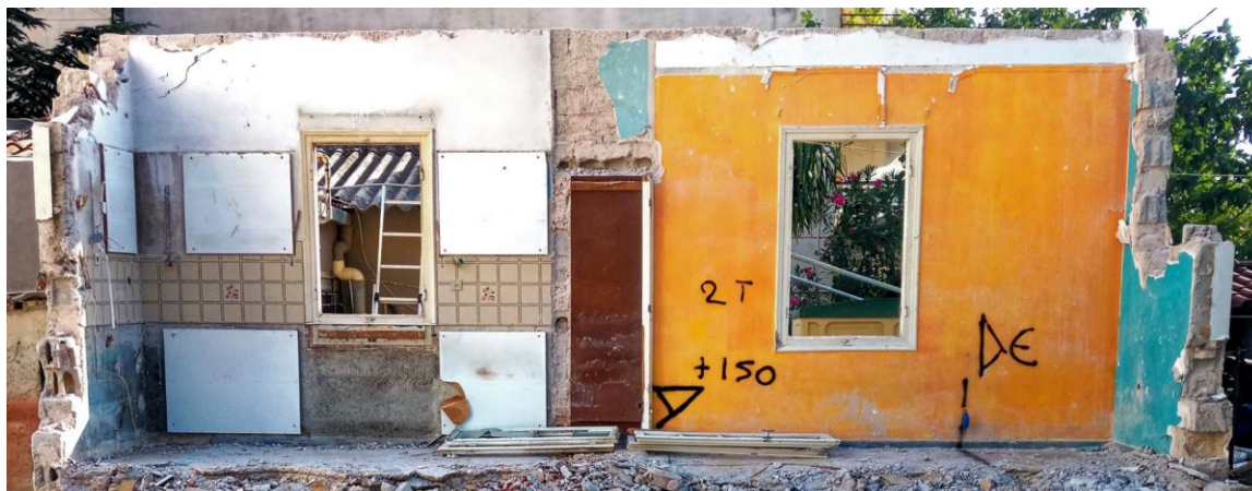
Εικόνα 8.3 Μερική κατεδάφιση κτιρίου που αποδίδει την τομή του σε φυσική κλίμακα.
