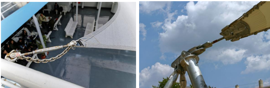
Εικόνες 6.67, 6.68 Διαφορετικές περιπτώσεις απόληξης τεντών στο σημείο στήριξης με ενισχύσεις αντίστοιχες της κλίμακας κατασκευής τους και των τάσεων που παραλαμβάνουν.
