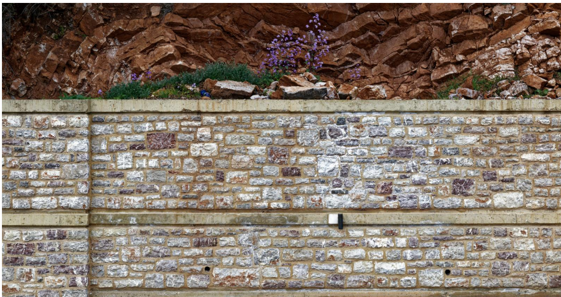
Εικόνα 6.2 Αναλημματικός τοίχος από σκυρόδεμα και επένδυση με ημιλαξευτούς λίθους, Καρπενήσι.
