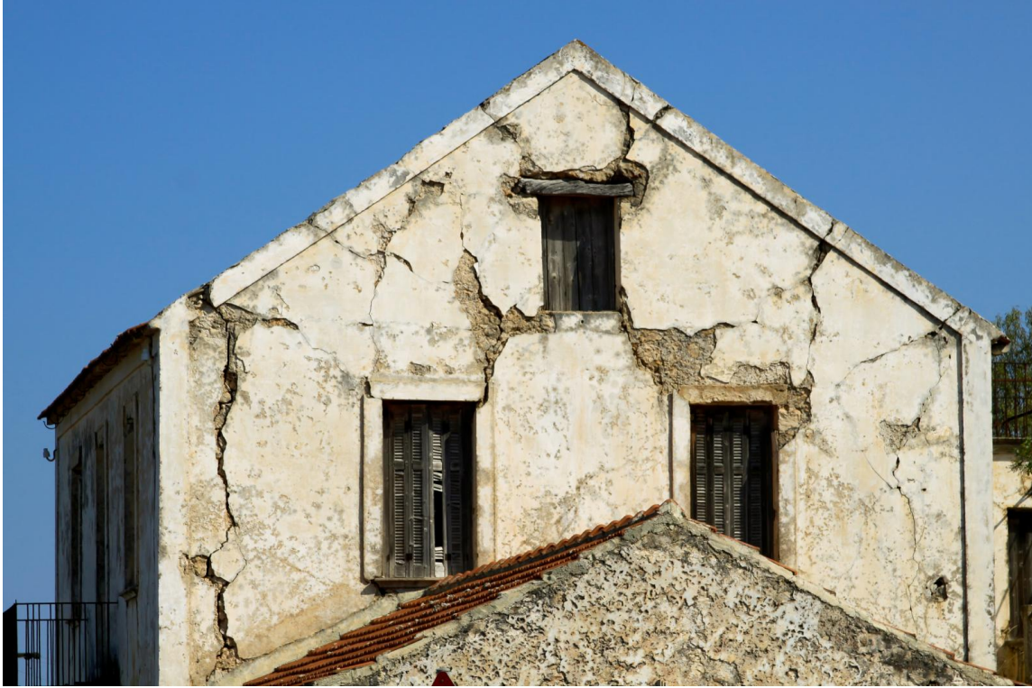
Εικόνα 1.34 Κτίριο από λιθοδομή και δίρριχτη στέγη με κεραμίδια. Είναι εμφανώς, αθροιστικά αποτυπωμένα, τα σημάδια των σεισμών των τελευταίων τριάντα ετών στην τοιχοποιία των όψεων. Κοθριάς, Κεφαλονιά.
