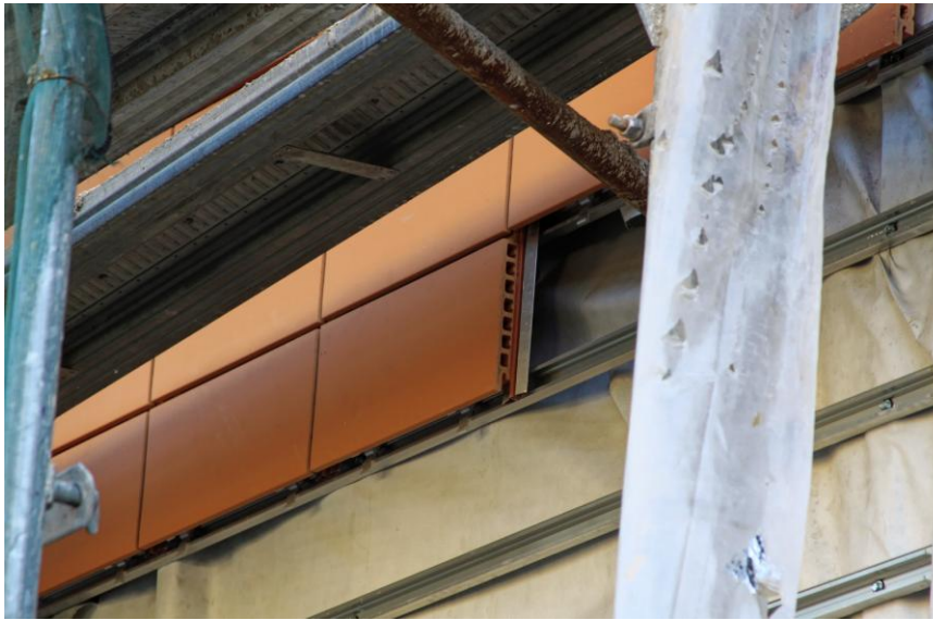
Εικόνα 4.12 Αεριζόμενη όψη από κεραμικές πλάκες «κλίνκερ» αναρτημένες με μεταλλικούς οριζόντιους οδηγούς στερεωμένους στην όψη. Πίσω από τους οδηγούς διακρίνεται η διαπνεύουσα μεμβράνη που προστατεύει από το νερό της βροχής.
