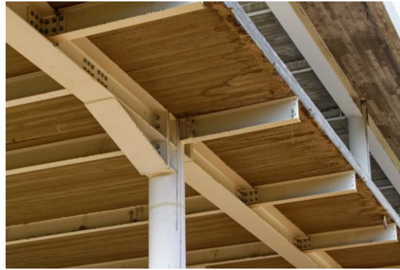
Εικόνες 6.87, 6.88 Στην πρώτη εικόνα, μεταλλικός σκελετός κτιρίου στον οποίο διακρίνονται καθαρά τα διαγώνια στοιχεία ακαμψίας, καθώς και οι διατημητικοί ήλοι στο άνω πέλμα των δοκών όπου θα σκυροδετηθεί απευθείας η πλάκα οπλισμένου σκυροδέματος, όπως φαίνεται στη δεύτερη εικόνα.
