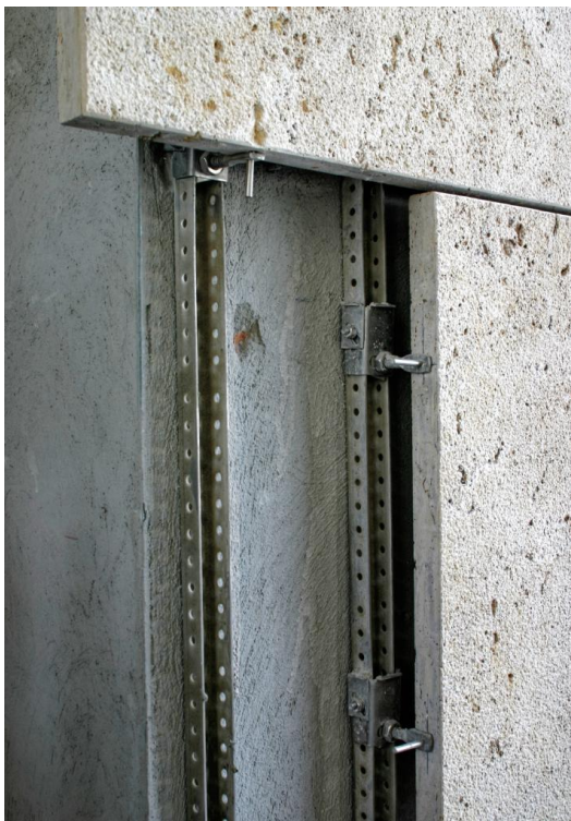
Εικόνα 4.8 Λεπτομέρεια ανάρτησης λίθινων πλακών από κατακόρυφους οδηγούς στην όψη του Δημαρχείου Θεσσαλονίκης. Αρχιτέκτονες Τ. Μπίρης, Δ. Μπίρης, Θεσσαλονίκη 2010.
