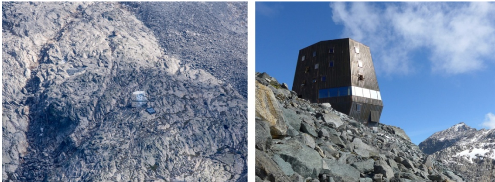
Εικόνα 6.15 Monte Rosa Hut , 2009, και Schwarzenstein Hut , 2018.
