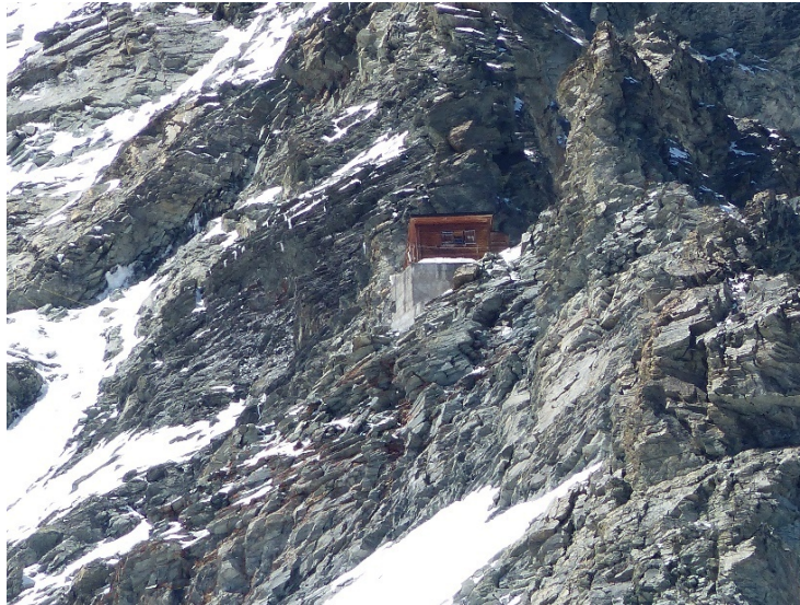
Εικόνα 6.5 Solvay Hut, Matterhorn, 1917. Το καταφύγιο ξεχωρίζει για την απόκρημνη τοποθεσία του, «σκαρφαλωμένο» στις απότομες και δυσπρόσιτες ορθοπλαγιές του Matterhorn.
