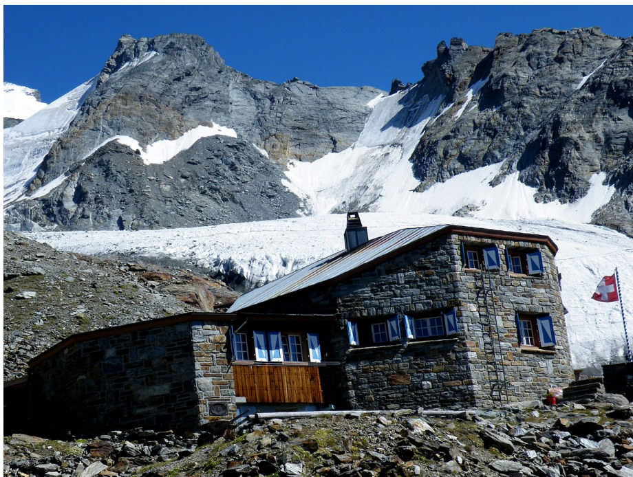
Εικόνα 6.11 Dom Hut, 1957. Χαρακτηριστικό είναι το πολυγωνικό σχήμα της κάτοψης ως προσπάθεια διαχείρισης των ανεμοπιέσεων.
