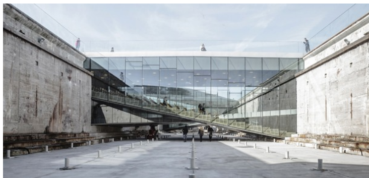
Εικ. 0.67 Μετατροπή της δεξαμενής ναυπήγησης σε ναυτικό μουσείο της Δανίας _ Οι εναέριες γέφυρες της επέμβασης αφήνουν ελεύθερη την περιπλάνηση στην αυλή του μουσείου για την ανάδειξη του κοίλου και των ιχνών της πρώην δεξαμενής ναυπήγησης.
