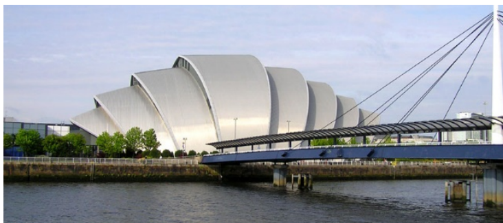
Εικ. 0.100 Άποψη της Bell's Bridge προς τη βόρεια όχθη, στο Armadillo.
