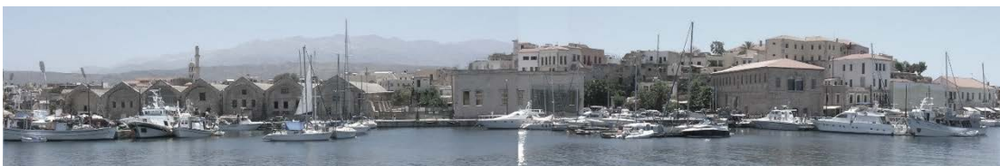
Εικ. 0.28 Άποψη της βόρειας πλευράς των νότιων νεωρίων: α. συγκρότημα επτά νεωρίων πριν την αποκατάσταση, β. τελωνείο κατά τις εργασίες επανάχρησης ως Θέατρο Μ. Θεοδωράκης μετά την αποκατάσταση του παλαιού τελωνείου, γ. Κ.Α.Μ., μετά την αποκατάσταση του Μεγάλου Αρσεναλίου.
