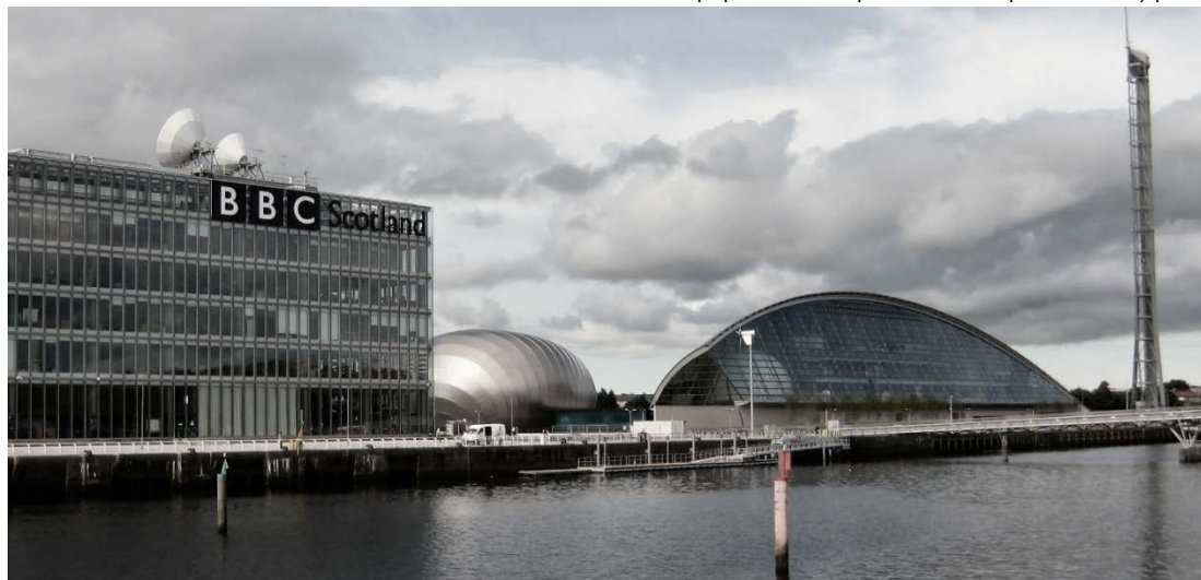
Εικ. 0.91 Άποψη των νέων κτιρίων στη νότια όχθη του ποταμού Clyde: BBC Scotland, IMAX, Science Mall, Πύργος της Γλασκώβης.
