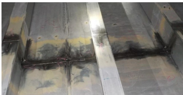
Εικ. 3.83 Προετοιμασία επιφανειών με τριβεία.
