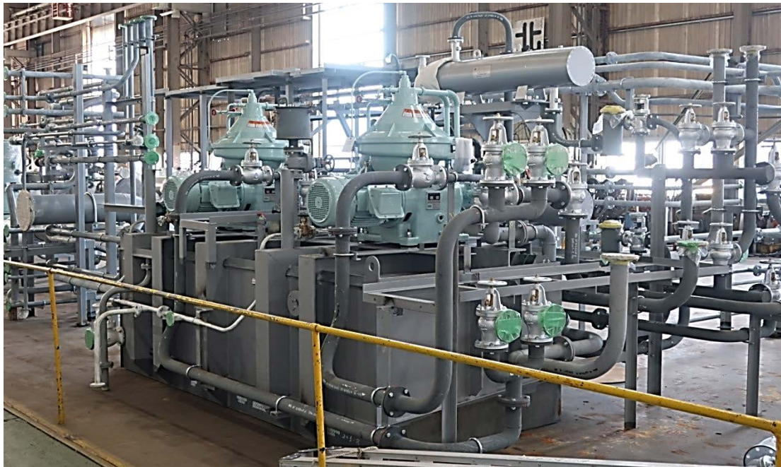
Εικ. 3.57 Προκατασκευή δικτύου εντός του σωληνουργείου.
