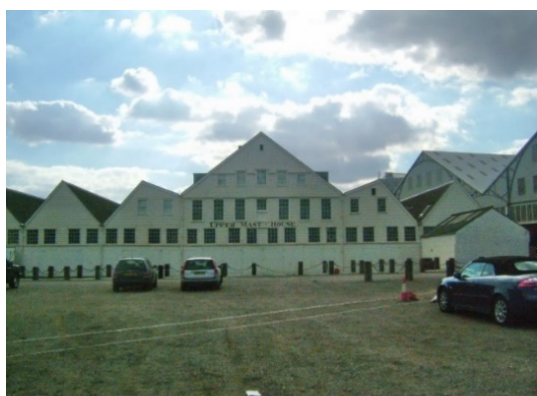
Εικ. 2.37 Το Mast House and Mold Loft (1753-8) είναι ένα ξύλινο κτίριο, όπου στο ισόγειο κατασκευάζονταν και αποθηκεύονταν ιστοί και στο πάτωμα του παταριού σχεδιάζονταν οι γραμμές του πλοίου.
