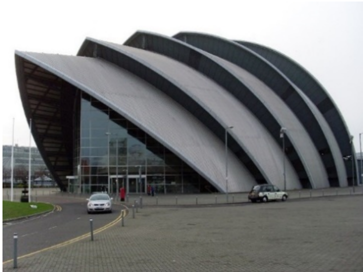
Εικ. 0.102 Αμφιθέατρο SEC Armadillo. Άποψη προς την είσοδο.
