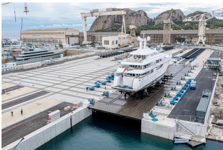
Εικ. 3.19 Σύστημα μηχανικής ανέλκυσης.
