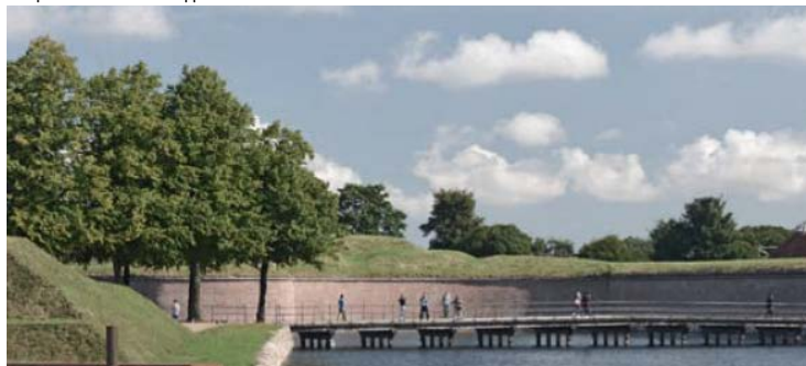
Εικ. 0.65 Στην ανάπλαση του τοπίου, η ξύλινη γέφυρα ιχνογραφεί παλαιά όρια της οχύρωσης, συνδέοντας την προκουμαία με τον αναγεννημένο «προμαχώνα».
