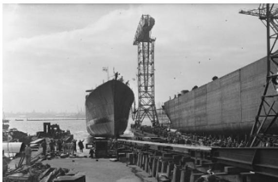
Εικ. 3.1 Ναυπήγηση σε επικλινές επίπεδο. Χρήση γερανών περιστρεφόμενου προβόλου.
