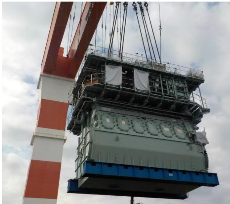
Εικ. 3.92 Τοποθέτηση κύριας μηχανής σε ένα κομμάτι.
