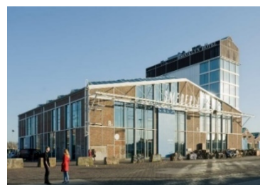
Εικ. 0.167 Smederij. Άποψη της αίθουσας σφυρηλάτησης κατά τις εργασίες αποκατάστασής της.
