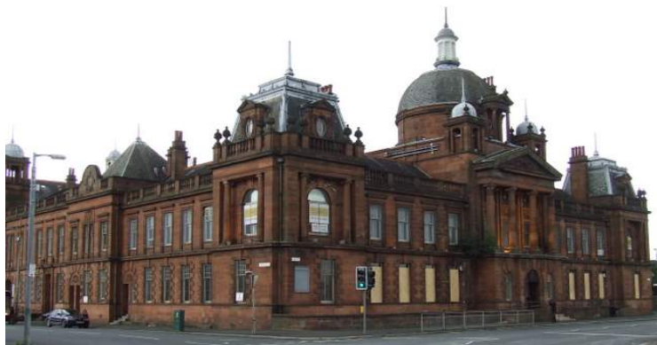
Εικ. 0.84 Το κτίριο του Govan Town Hall, μετά την επανάχρηση ως Film City.
