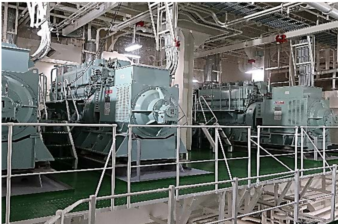
Εικ. 3.97 Ηλεκτρογεννήτριες κατά τη δοκιμή των αυτοματισμών κατανομής φορτίου.
