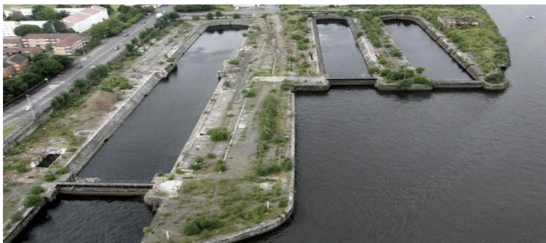
Εικ. 0.76 Αεροφωτογραφία των ιστορικών δεξαμενών ναυπήγησης στο Govan.
