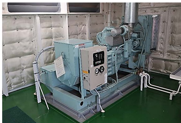
Εικ. 3.97 Ηλεκτρογεννήτριες κατά τη δοκιμή των αυτοματισμών κατανομής φορτίου.
