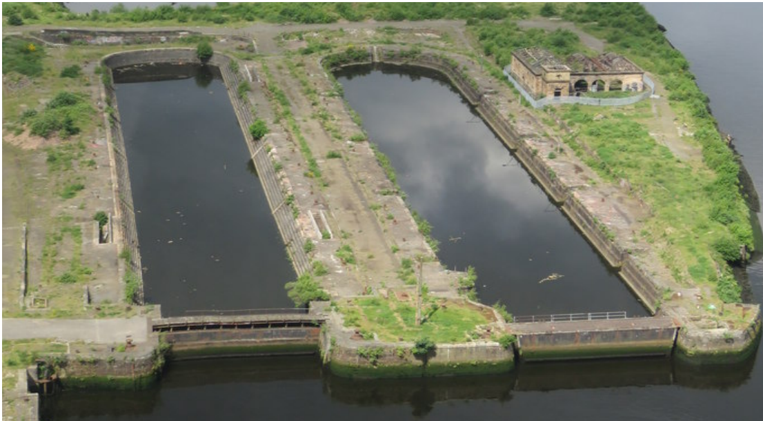
Εικ. 3.10 Λιθόκτιστες δεξαμενές που φράσσονται από πλωτές θύρες. Govan Graving Docks, Clyde, Γλασκώβη.
