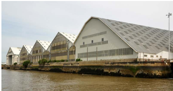
Εικ. 2.43 Covered Slips, Chatham Dockyard. Άποψη από τον ποταμό των στεγασμένων ολισθητήρων Νο3, 4, 5, 6 & 7 (από δεξιά).
