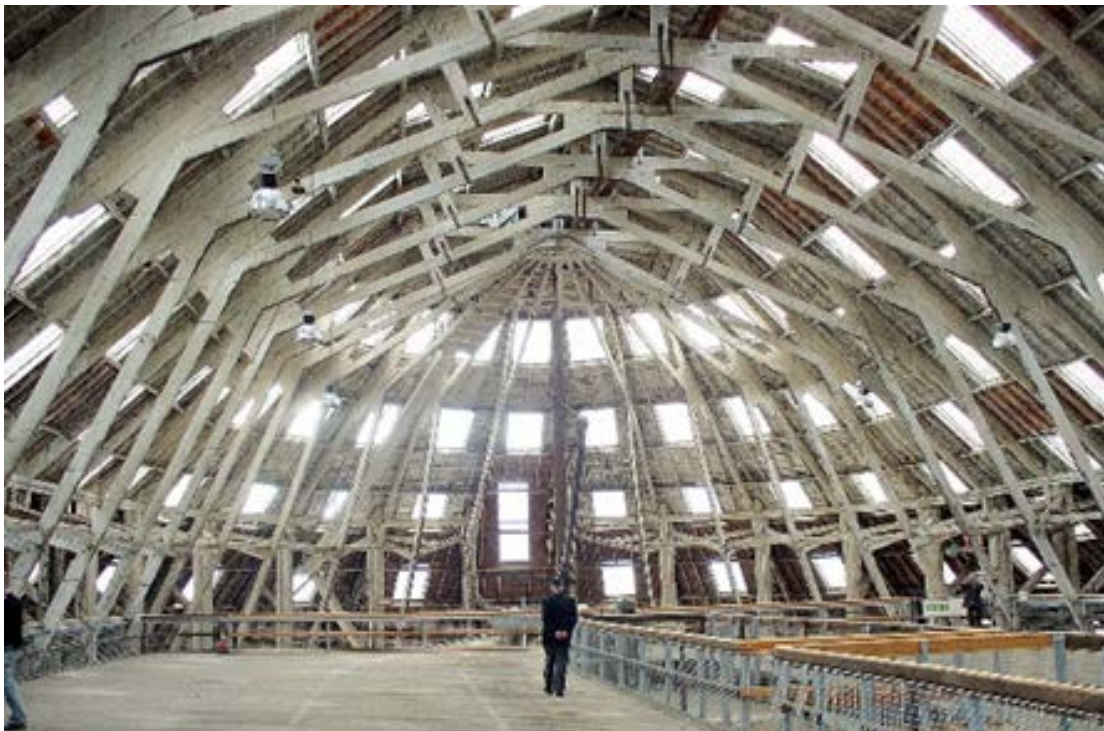
Εικ. 2.44 Εσωτερική άποψη της ξύλινης κάλυψης του ολισθητήρα Νο 3.
