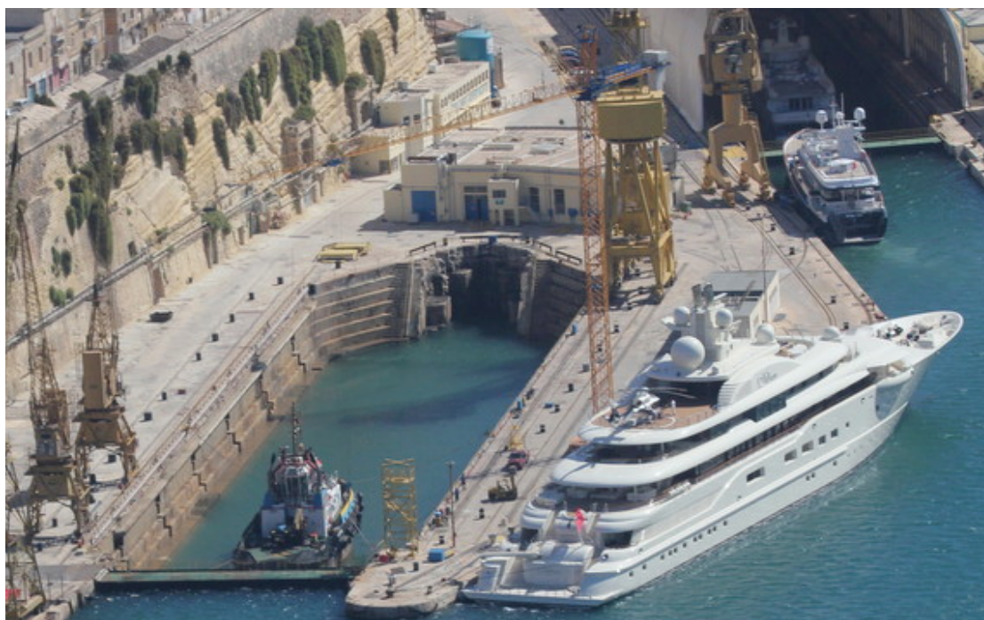
Εικ. 3.9 Λιθόκτιστη κλιμακωτή δεξαμενή. Palumbo Shipyard, Μάλτα.
