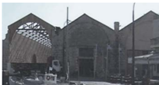
Εικ. 0.34 Άποψη των ανατολικών νεωρίων κατά τη φάση αποκατάστασης της στέγης του νεωρίου προς τον λιμενοβραχίονα.
