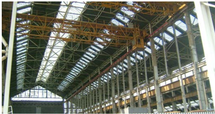
Εικ. 2.45 Covered Slip No 7. Σχεδιασμένο από τον Col GTGreene, ένα πρώιμο παράδειγμα μεταλλικής οροφής.
