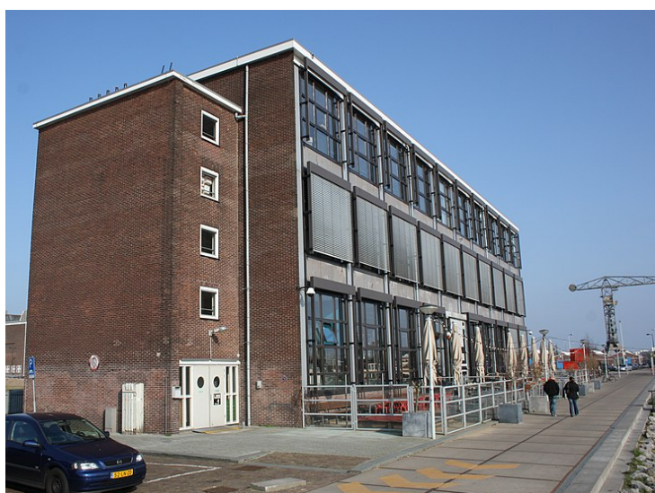
Εικ. 0.151 Baanderij_NDSM. Άποψη του κτιρίου μετά την αποκατάσταση και επανάχρηση.
