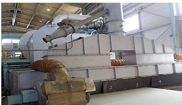
Εικ. 3.22 Αμμοβολή και βαφή επιπέδων ελασμάτων.
