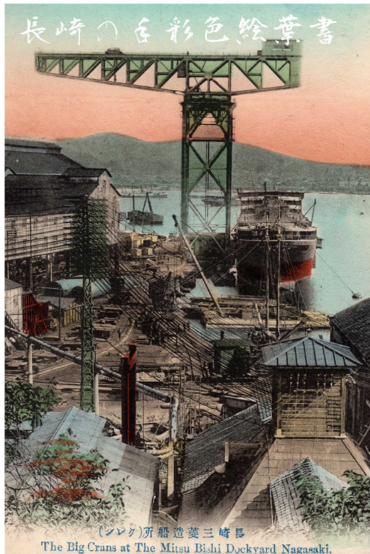
Εικ. 2.53 Ο γιγάντιος ηλεκτροκίνητος γερανός της Mitsubishi στο ναυπηγείο Nagasaki (1904).
