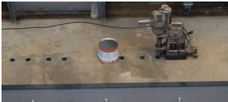
Εικ. 3.88 Διάτρηση των οπών πάκτωσης της κύριας μηχανής.
