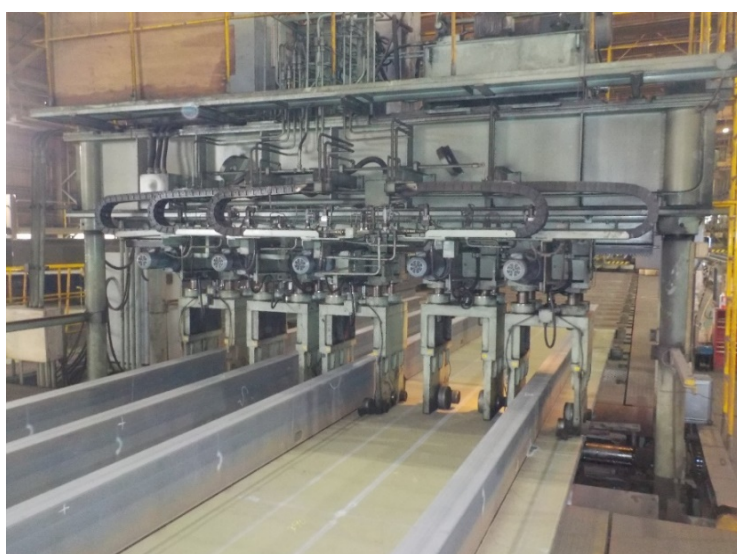
Εικ. 3.30 Έλεγχος επιφανειών και αποκατάσταση επιπεδότητας.
