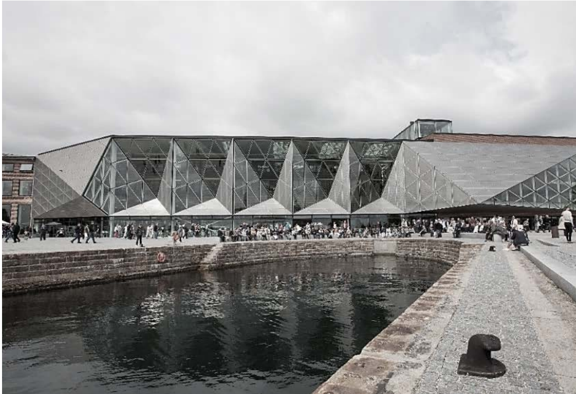
Εικ. 0.52 Άποψη της βιβλιοθήκης από την αυλή του πρώην ναυπηγείου.
