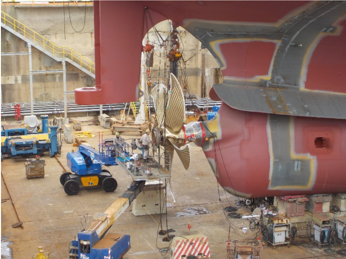
Εικ. 3.89 Τοποθέτηση έλικας.
