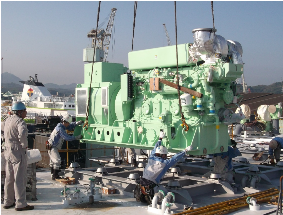
Εικ. 3.91 Τοποθέτηση γεννήτριας επί ελαστικών βάσεων.
