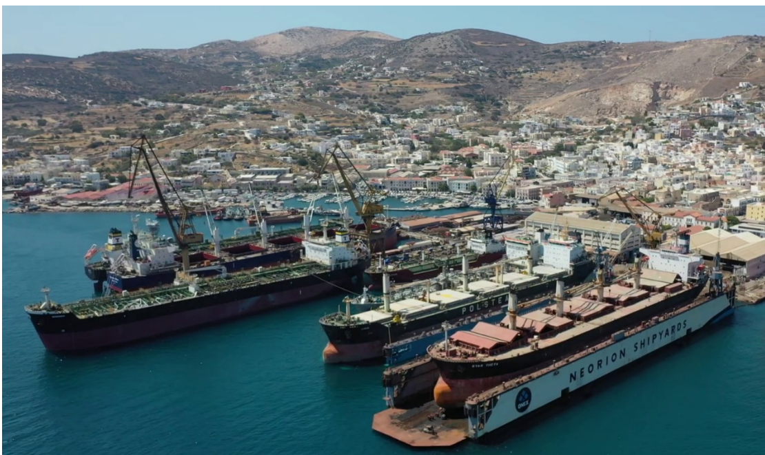
Εικ. 3.18 Πλωτή δεξαμενή εξυπηρετούμενη από γερανούς μεταβλητού ανοίγματος.
