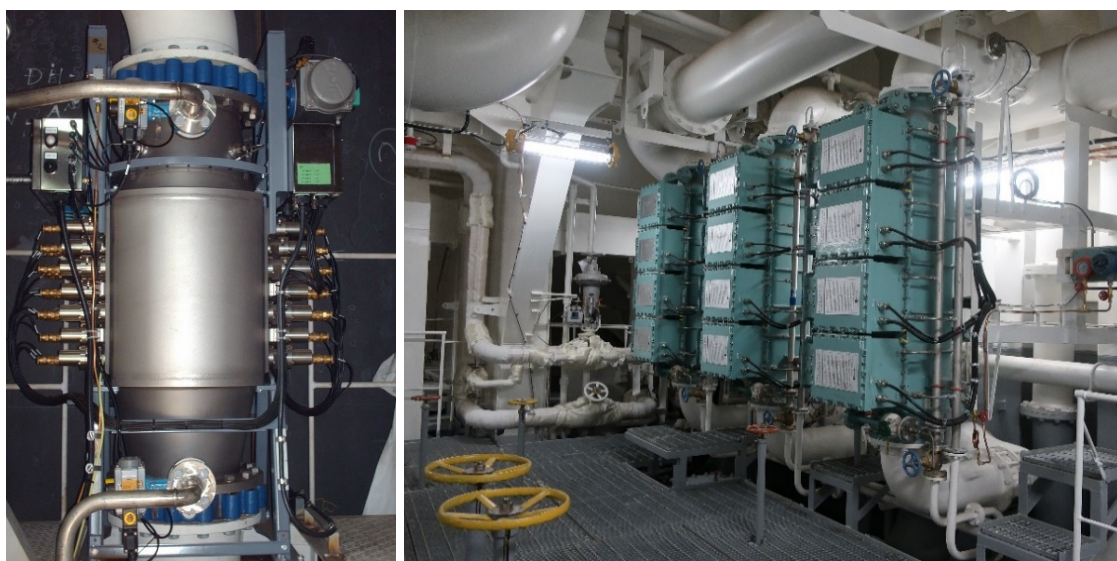
Εικ. 3.105 Σύστημα επεξεργασίας έρματος με ηλεκτρόλυση.
