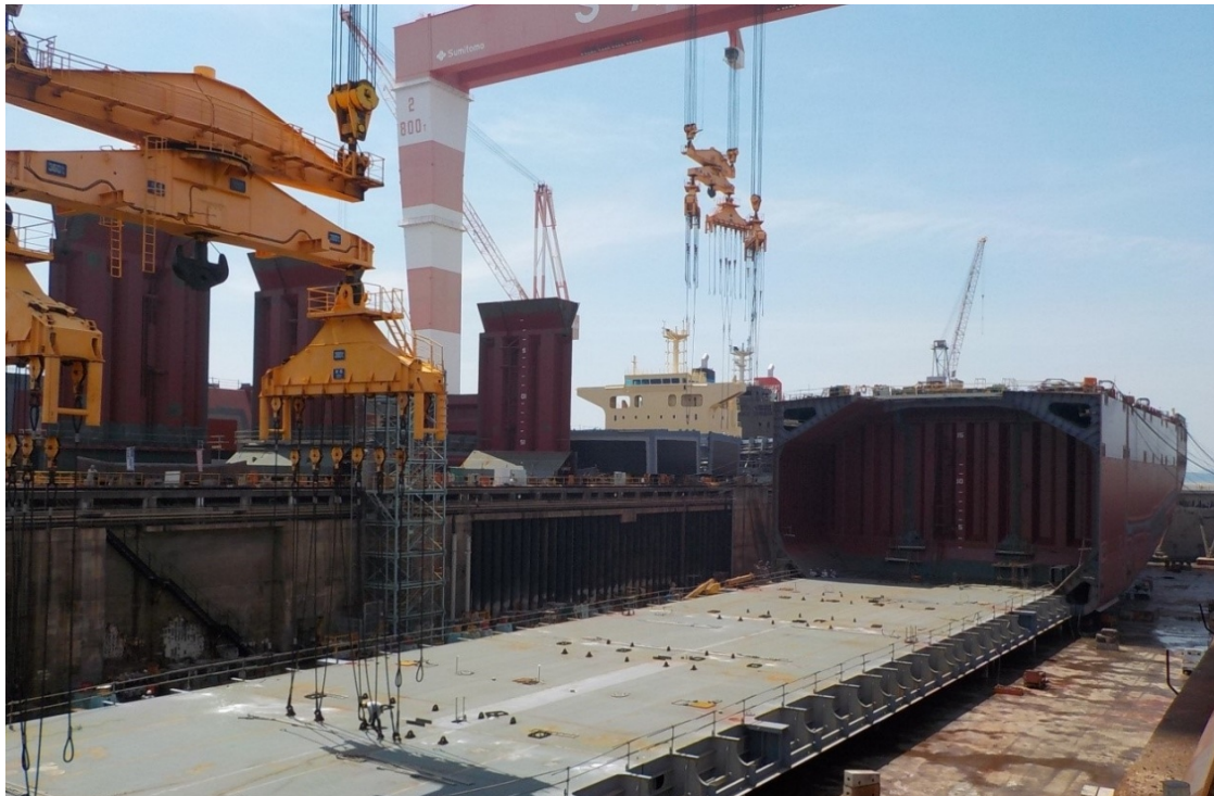
Εικ. 3.13 Ενδιάμεσο στάδιο ανέγερσης μετά τη μετατόπιση της πρύμνης.
