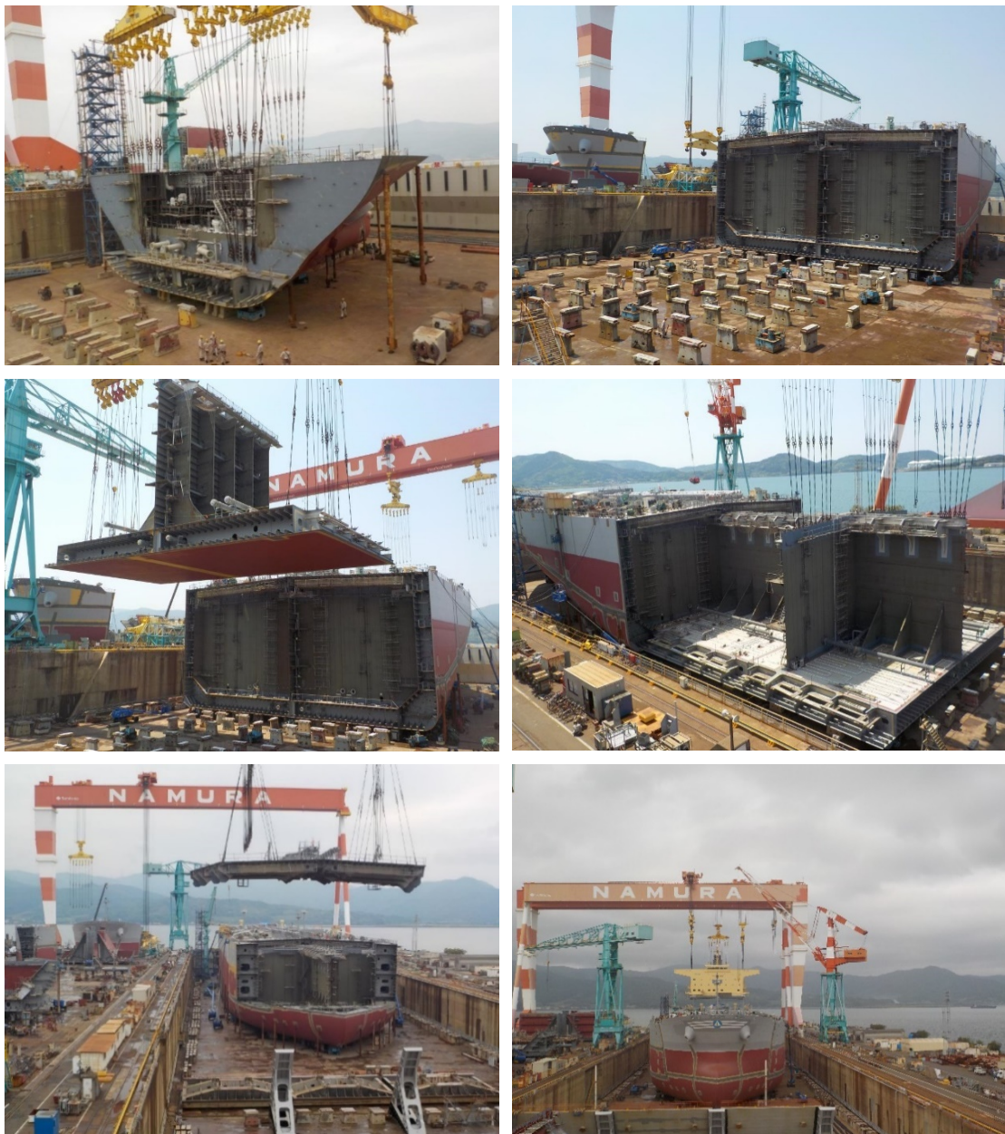
Εικ.3.73 - Εικ. 3.78 Ανέγερση προκατασκευασμένων τομέων σε μόνιμη δεξαμενή.
