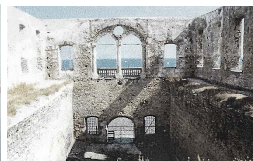
Εικ. 0.25 Άποψη του εσωτερικού του Μεγάλου Αρσεναλιού πριν τη σύγχρονη επέμβαση.
