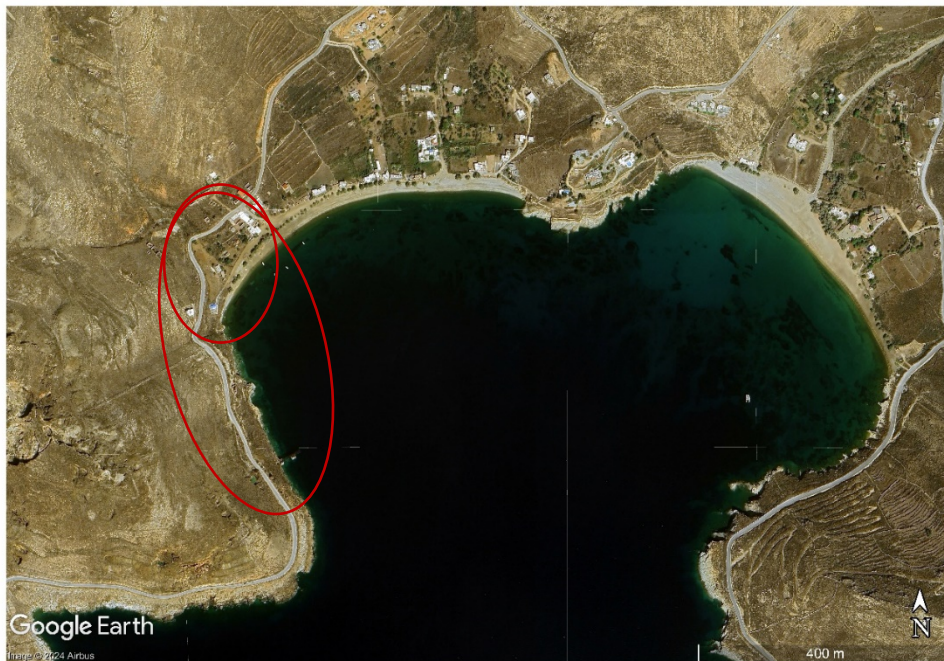
Εικόνα 6-3. Ο όρμος του Κουταλά. Με κόκκινο περίγραμμα η περιοχή των εγκαταστάσεων. Στο μικρό περίγραμμα τα εργαστήρια, αποθήκες και κατοικίες. Στο μεγάλο περίγραμμα η σκάλα και η πλατεία φόρτωσης μεταλλευμάτων. Υπόβαθρο: Google Earth. Επεξεργασία: Ερευνητική Ομάδα ΕΜΠ, 2024.
