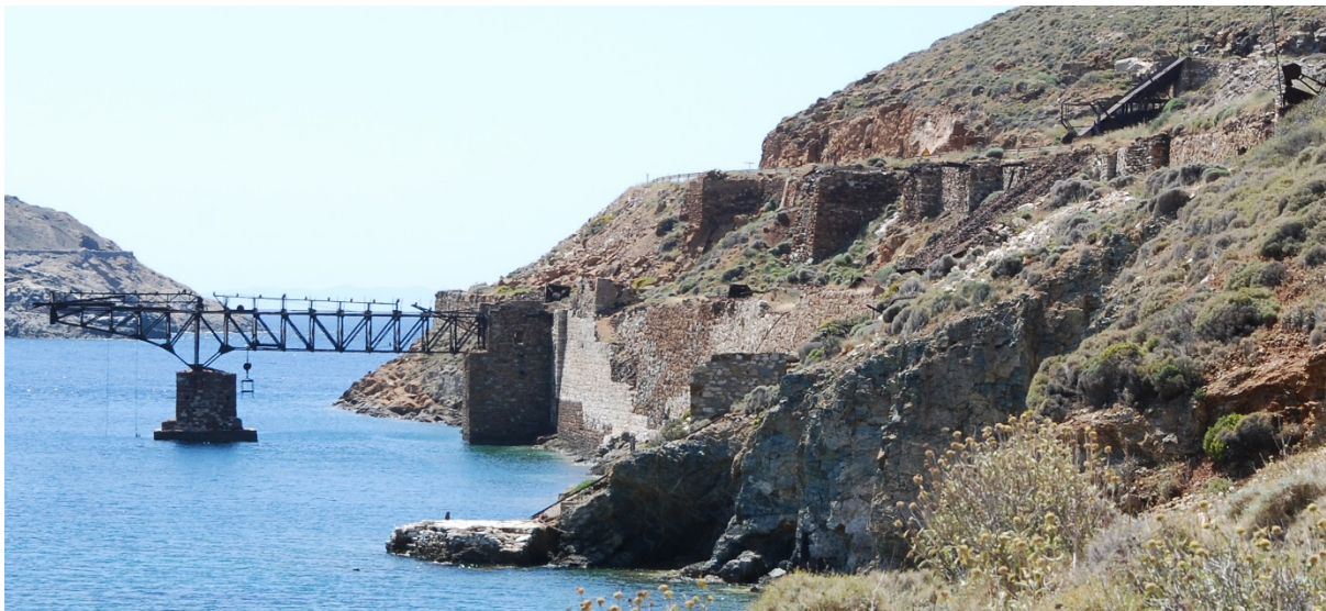
Εικόνα 6-12. Η σκάλα φόρτωσης του Κουταλά. Διακρίνονται τα δύο διαμορφωμένα επίπεδα με τους αναλημματικούς τοίχους, σε σχετικά καλή κατάσταση διατήρησης. Φωτό: Ερευνητική Ομάδα ΕΜΠ, 2024.
