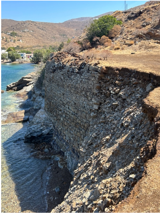
Εικόνα 9-16. Σκάλα φόρτωσης Μεγάλου Λειβαδιού. Κατάρρευση τμημάτων του παράκτιου αναλημματικού τοίχου (αριστερά στη θέση της πλατείας φόρτωσης μεταλλευμάτων, δεξιά είναι η θέση ακριβώς παραπλεύρως και ανατολικά της σκάλας). Φωτό: Ερευνητική Ομάδα, Μάιος 2024.
