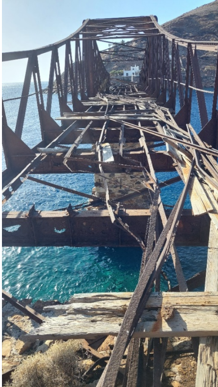
Εικόνα 9-30. Σκάλα φόρτωσης Μεγάλου Λειβαδιού. Γενική άποψη και διάτρηση μεταλλικών μελών. Φωτό: Ερευνητική Ομάδα, Μάιος 2024.
