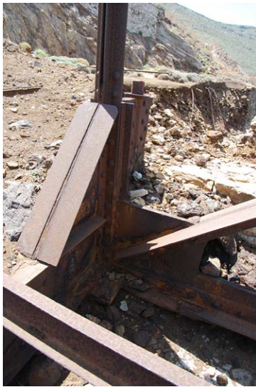
Εικόνα 9-13 και Εικόνα 9-14. Σκάλα φόρτωσης Μεγάλου Λειβαδιού. Κατάρρευση τμημάτων του παράκτιου αναλημματικού τοίχου, επί του οποίου εδράζεται με αγκύρια ο μεταλλικός φορέας της σκάλας φόρτωσης. Φωτό: Ερευνητική Ομάδα, Μάιος 2024.
