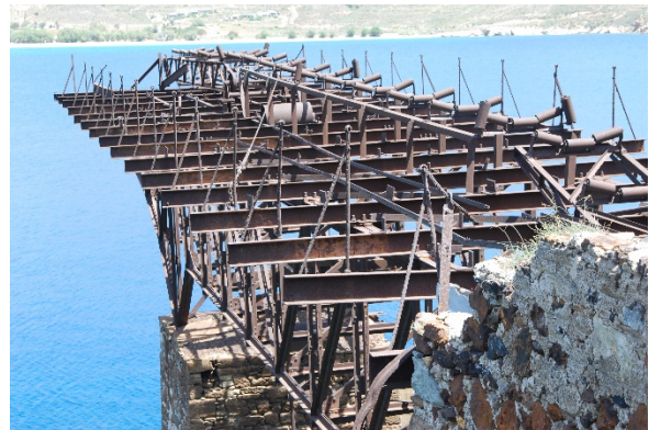
Εικόνα 6-13 και Εικόνα 6-14. Λεπτομέρειες της έδρασης και του μεταλλικού φορέα της σκάλας φόρτωσης του Κουταλά. Φωτό: Ερευνητική Ομάδα ΕΜΠ, 2024.
