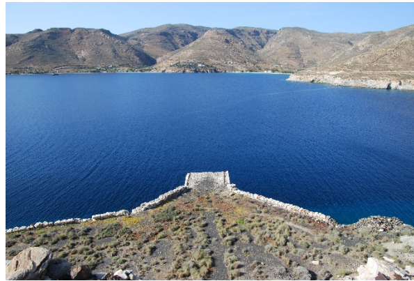
Εικόνα 9-54. Πλατεία φόρτωσης με διαμόρφωση προεξέχοντος τμήματος για την στερέωση σκάλας φόρτωσης (σε πρόβολο). Φωτό: Ερευνητική Ομάδα ΕΜΠ, 2024.
