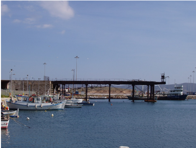
Εικόνα 4-16. Γαλλική Σκάλα στο λιμάνι του Λαυρίου. Φωτό: Αρχείο Εργαστηρίου Αστικού Περιβάλλοντος ΕΜΠ.
