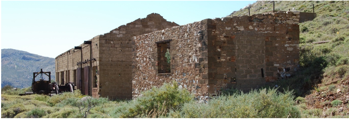
Εικόνα 6-27. Το συγκρότημα του μηχανοστασίου στον Κουταλά. Φωτό: Ερευνητική Ομάδα ΕΜΠ, 2024.
