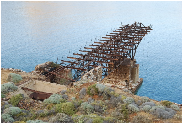
Εικόνα 6-13 και Εικόνα 6-14. Λεπτομέρειες της έδρασης και του μεταλλικού φορέα της σκάλας φόρτωσης του Κουταλά. Φωτό: Ερευνητική Ομάδα ΕΜΠ, 2024.
