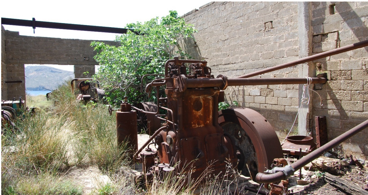
Εικόνα 6-28. Ο μηχανολογικός εξοπλισμός στο εσωτερικό του μηχανοστασίου. Φωτό: Ερευνητική Ομάδα ΕΜΠ, 2024.
