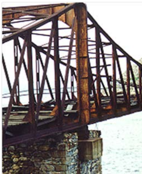
Εικόνα 9-7. Σκάλα φόρτωσης Μεγάλου Λιβαδιού. Λεπτομέρεια έδρασης μεταλλικού φορέα επί του πυλώνα. Φωτό και Σχέδιο: Ερευνητική Ομάδα ΕΜΠ, 2024.
