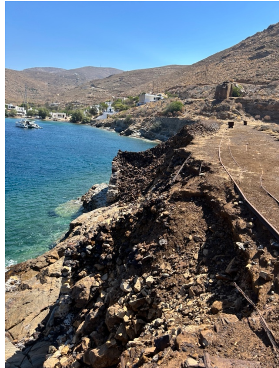
Εικόνα 9-16. Σκάλα φόρτωσης Μεγάλου Λειβαδιού. Κατάρρευση τμημάτων του παράκτιου αναλημματικού τοίχου (αριστερά στη θέση της πλατείας φόρτωσης μεταλλευμάτων, δεξιά είναι η θέση ακριβώς παραπλεύρως και ανατολικά της σκάλας). Φωτό: Ερευνητική Ομάδα, Μάιος 2024.
