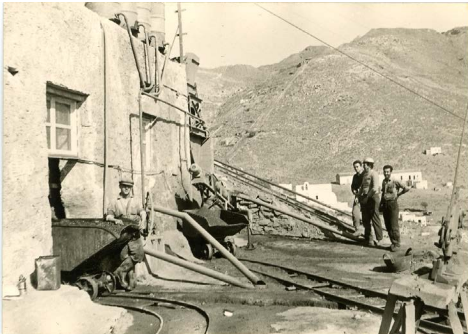
Εικόνα 6-30. Πρόδρομο εργοστάσιο εμπλουτισμού στον Κουταλά το 1961. Πηγή: Αρχείο Α.Ζ. Φραγκίσκου.
