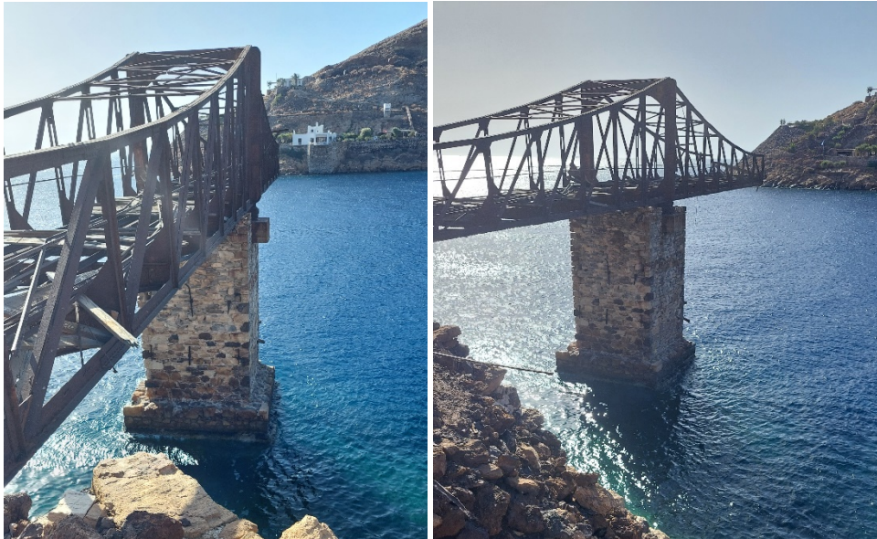
Εικόνα 9-34. Σκάλα φόρτωσης Μεγάλου Λειβαδιού. Άποψη πυλώνα. Ο πυλώνας έχει κλίση 0,8-1,0 μοίρας από την κατακόρυφο στον διαμήκη άξονα προς τη θάλασσα. Φωτό: Ερευνητική Ομάδα, Μάιος 2024.
