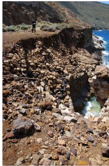
Εικόνα 9-13 και Εικόνα 9-14. Σκάλα φόρτωσης Μεγάλου Λειβαδιού. Κατάρρευση τμημάτων του παράκτιου αναλημματικού τοίχου, επί του οποίου εδράζεται με αγκύρια ο μεταλλικός φορέας της σκάλας φόρτωσης. Φωτό: Ερευνητική Ομάδα, Μάιος 2024.
