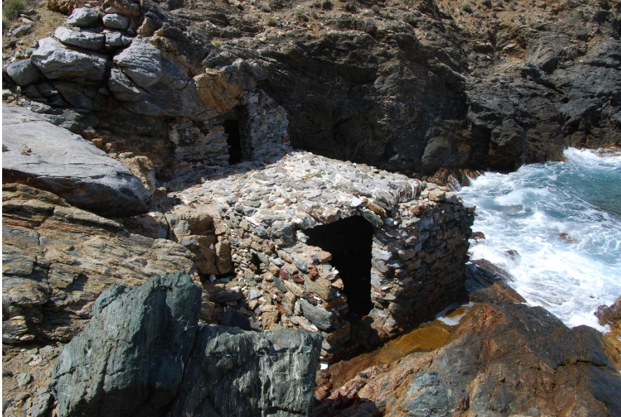
Εικόνα 6-25. Το κτίριο των ιαματικών λουτρών Αλμυρού. Φωτό: Ερευνητική Ομάδα ΕΜΠ, 2024.
