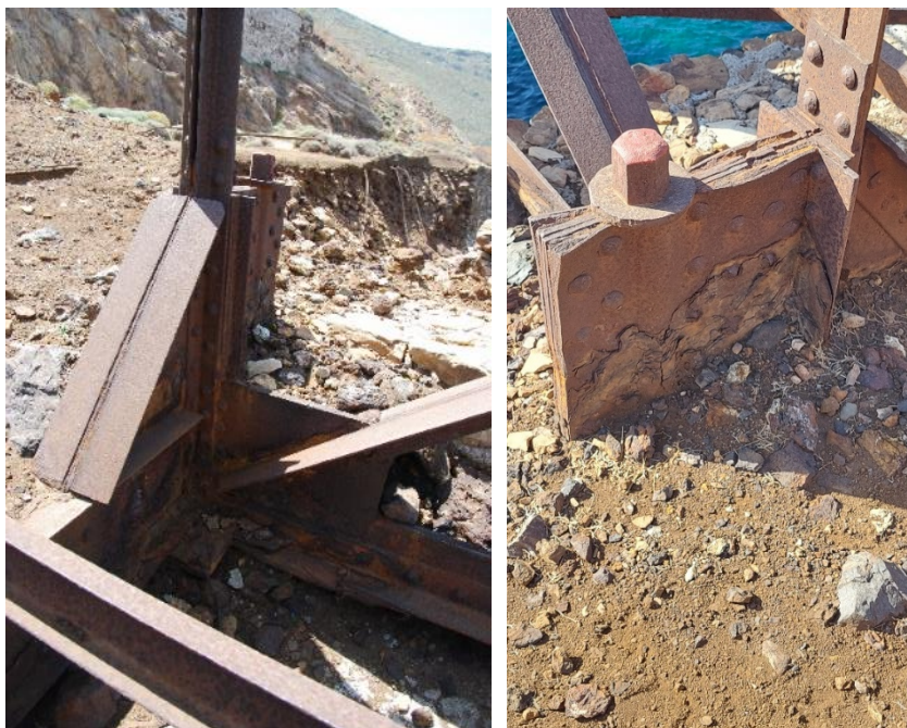
Εικόνα 9-33. Σκάλα φόρτωσης Μεγάλου Λειβαδιού. Λεπτομέρειες έδρασης επί του αναλημματικού τοίχου. Φωτό: Ερευνητική Ομάδα, Μάιος 2024.
