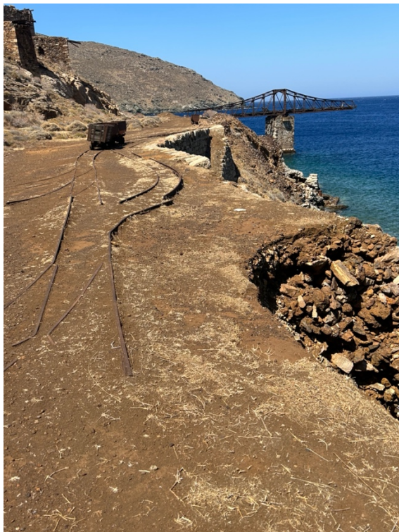
Εικόνα 9-17. Σκάλα φόρτωσης Μεγάλου Λειβαδιού. Κατάρρευση τμημάτων του παράκτιου αναλημματικού τοίχου (αριστερά φαίνεται πως οπισθοχωρεί η αστοχία απειλώντας και της ανάντη εγκαταστάσεις των σιδηροτροχιών με τα βαγόνια και δεξιά η αστοχία των σιδηροτροχιών με κρέμονται δυτικά της σκάλας φόρτωσης). Φωτό: Ερευνητική Ομάδα, Μάιος 2024.
