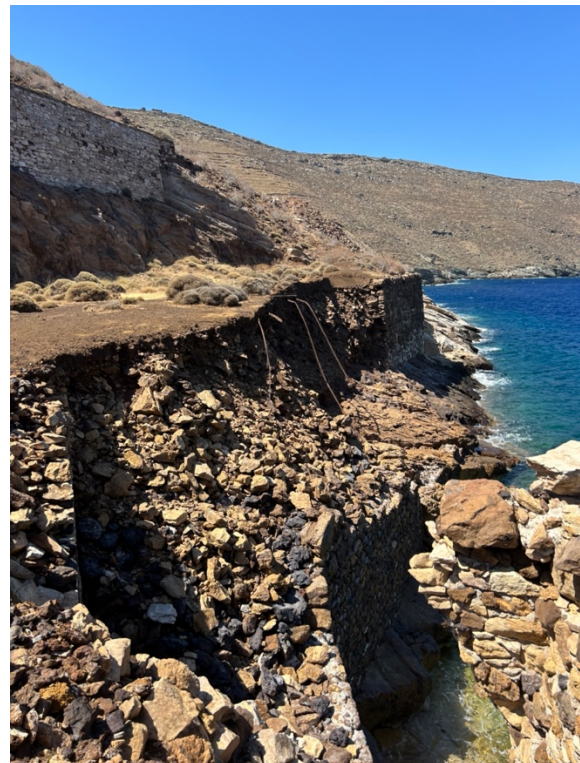
Εικόνα 9-17. Σκάλα φόρτωσης Μεγάλου Λειβαδιού. Κατάρρευση τμημάτων του παράκτιου αναλημματικού τοίχου (αριστερά φαίνεται πως οπισθοχωρεί η αστοχία απειλώντας και της ανάντη εγκαταστάσεις των σιδηροτροχιών με τα βαγόνια και δεξιά η αστοχία των σιδηροτροχιών με κρέμονται δυτικά της σκάλας φόρτωσης). Φωτό: Ερευνητική Ομάδα, Μάιος 2024.
