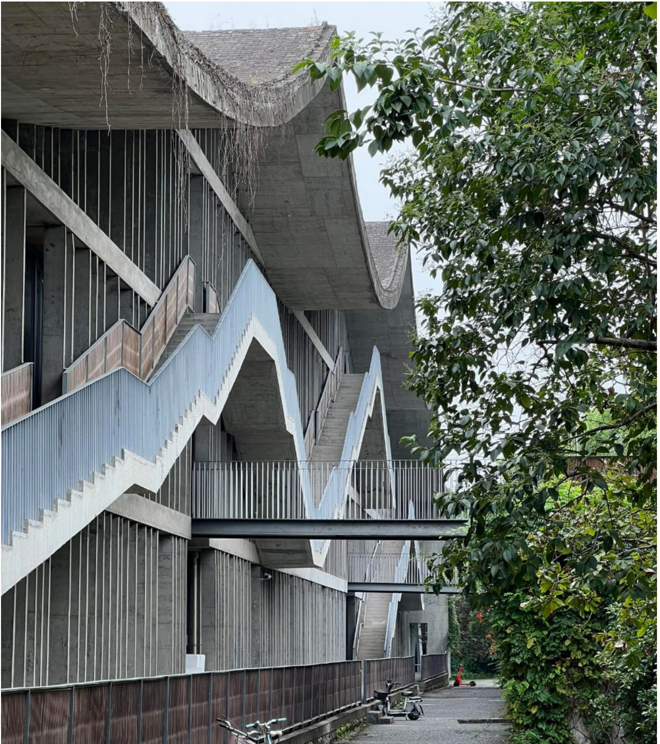
Εικόνα 2.2: Διαμόρφωση κεκλιμένων διαδρόμων στην πρόσοψη και στο εσωτερικό αίθριο των φοιτητικών εσίων της Σχολής Καλών Τεχνών στην πόλη Hangzhou. Academy of Arts, Wang Shu, 2002-07, Κίνα. [Φωτογραφία] Θεόδωρος Βενετσάνος (Copyright © Θεόδωρος Βενετσάνος. All Rights Reserved. Reproduced [or Adapted] with permission.)
