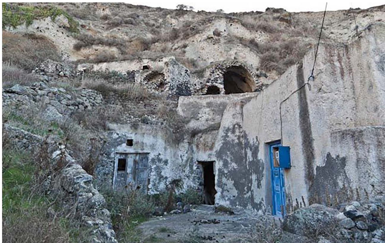
Εικόνα 9.21: Κατοικίες στην Αγριλιά, Θηρασιά. [Φωτογραφία] Ρίβα Λάββα
