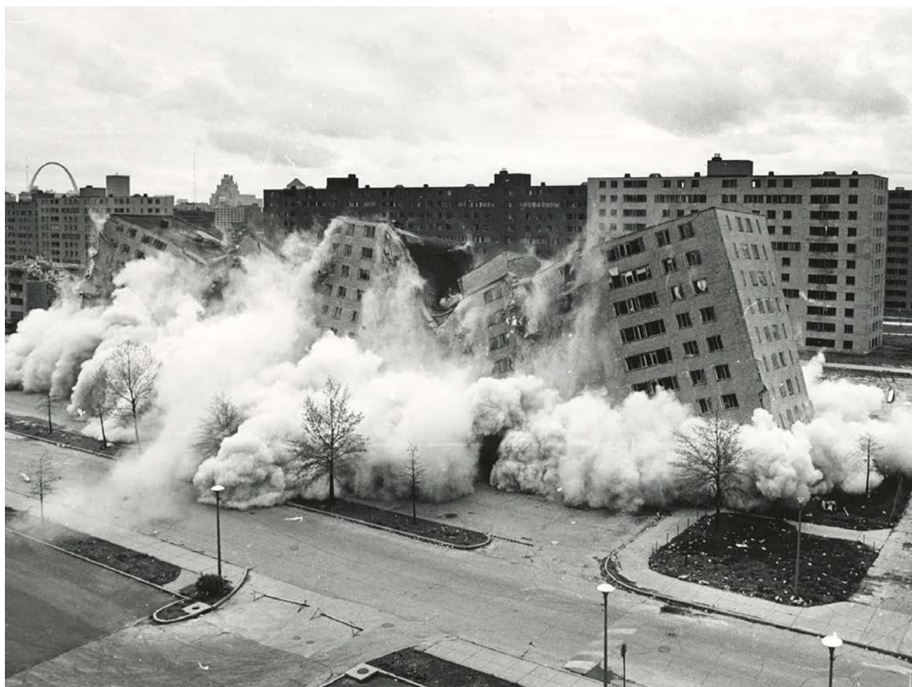
Εικόνα 9.26: Το δεύτερο στάδιο της κατεδάφισης του συγκροτήματος Pruitt-Igoe τον Απρίλιο του 1972. Ανακτήθηκε 5 Απριλίου 2023 από (PD), https://en.wikipedia.org/wiki/Pruitt%E2%80%93Igoe#/media/File:Pruitt-igoe_collapse-series.jpg
